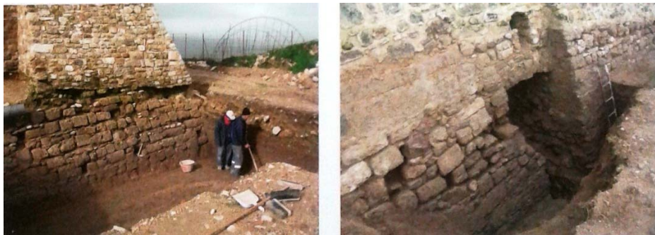
Fig. 10 – Immagini della messa in evidenza delle tecniche costruttive utilizzate per le fondazioni degli elevati.
