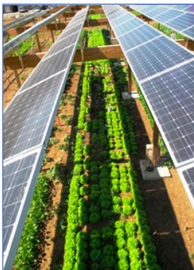
*Figura 29 – Esempio di colture agricole realizzate tra le file di pannelli fotovoltaici*
