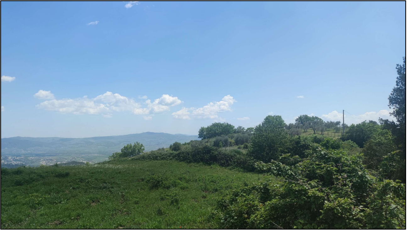
Figura 14.4: area piazzola di montaggio dell'aerogeneratore AL04
