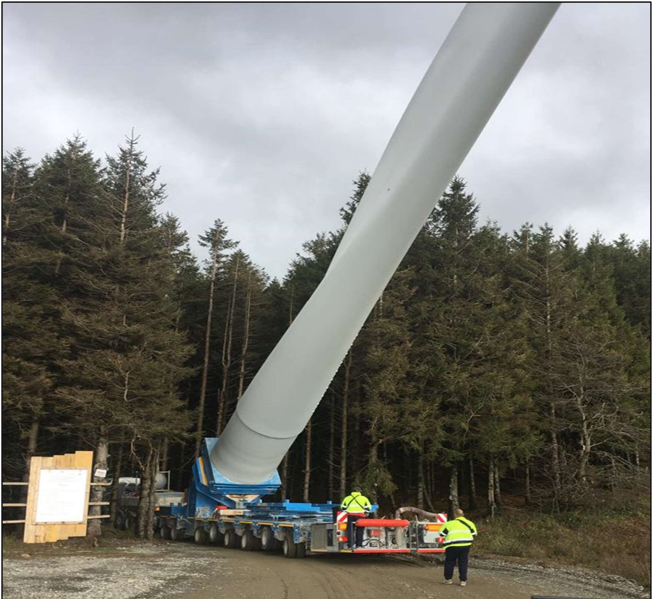
Figura 3.3: Trasporto con “Blade Lifter”
