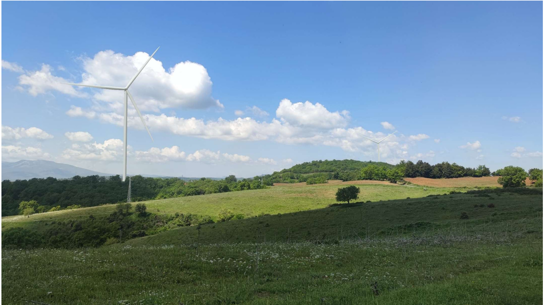
Foto 5b: Punto di ripresa fotografica C – 40,315487^{\circ} 16,189417^{\circ} – Direzione Foto 265^{\circ} – WTG AL 01 - AL 02 post operam
