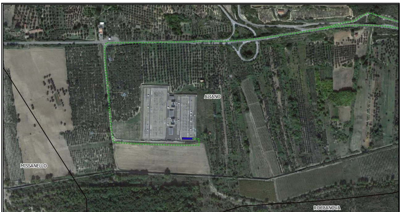
Figura 5.8.1: Individuazione su ortofoto dello stallo AT nella stazione Terna
