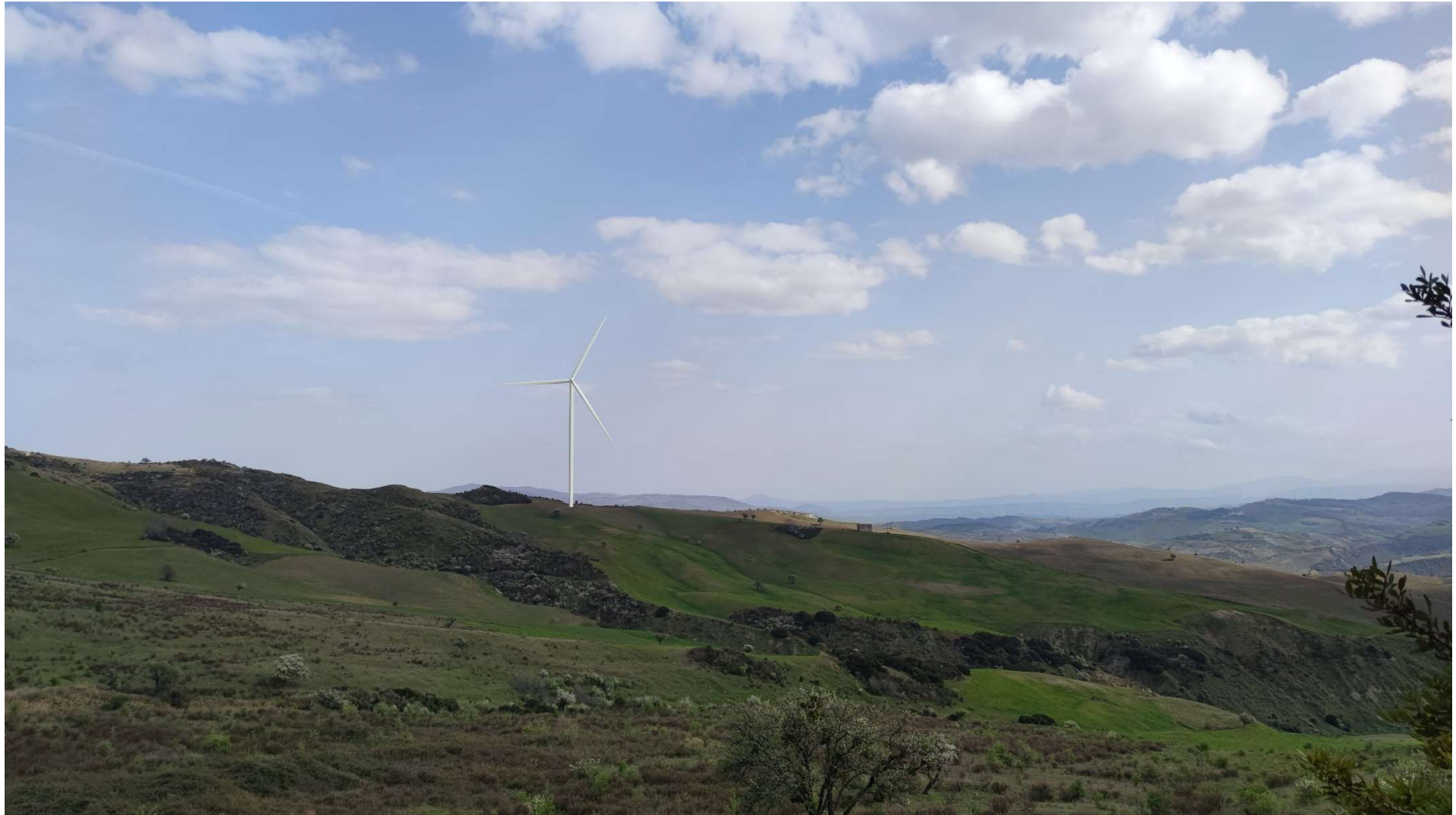
Foto 1b: Punto di ripresa fotografica A – 40,293241^{\circ} 16,214408^{\circ} – Direzione Foto 132^{\circ} – Vista area WTG AL 5 Post Operam
