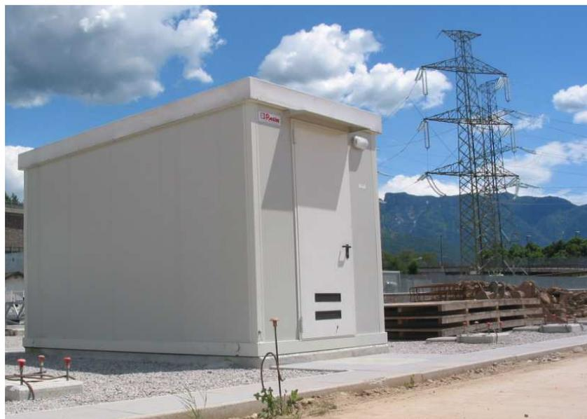
Fig. 13: Esempio di chioschi di stazione con verniciatura RAL 9002 bianco grigio.
