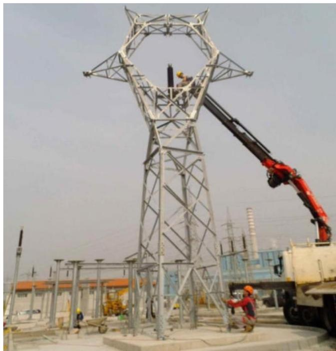
Figura 23 - Installazione di un sostegno all'interno della sotto stazione
