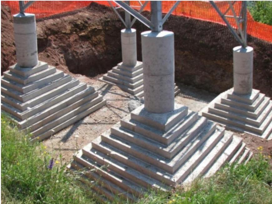
**Figura 24 - Area di micro-cantiere tipo per l'istallazione di un sostegno**
