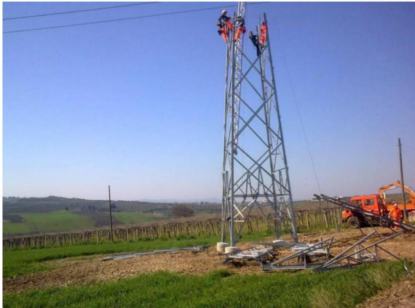
Figura 22 - Installazione di un sostegno all'interno dei micro cantieri
