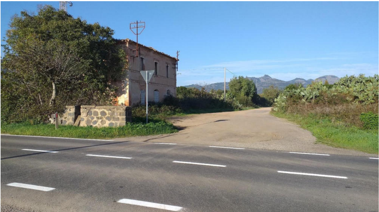
Figura 39 - Accesso all'ex ferrovia dalla SS126
