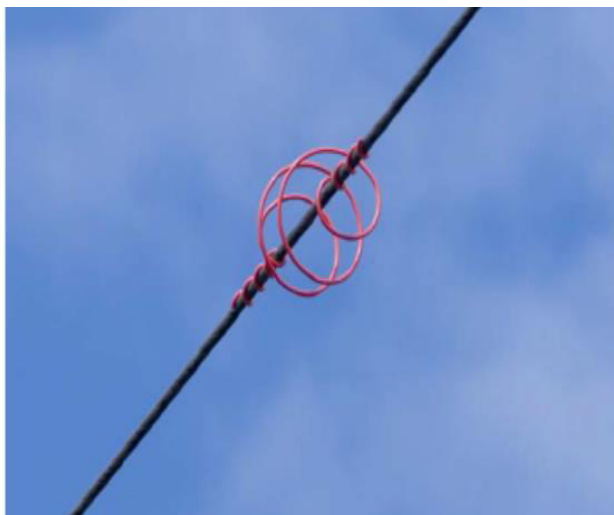
Figura 52 - Esempio di segnalatore di cavo
