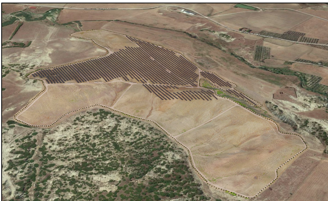
Figura 30: Vista da Nord-Est dell'agrivoltaico di progetto
