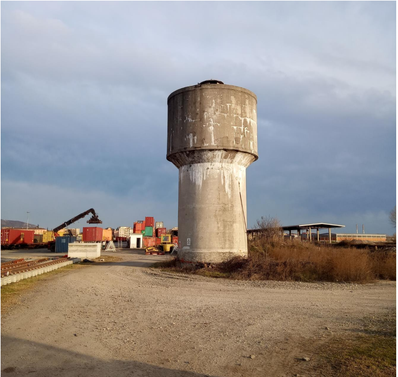
Fig. 3 – Torre piezometrica posta sul lato Est dello Scalo
