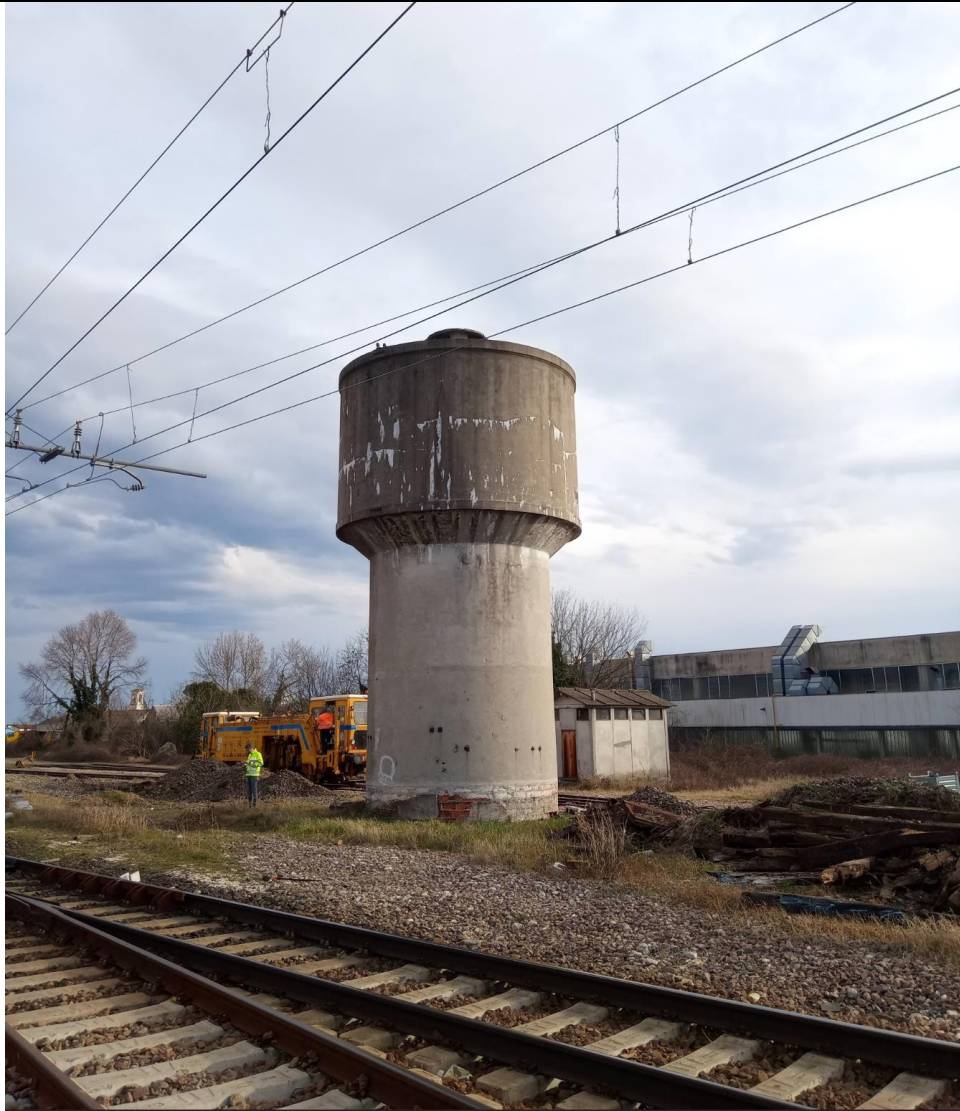
Fig. 6 - Torre piezometrica posta sul lato Ovest dello Scalo
