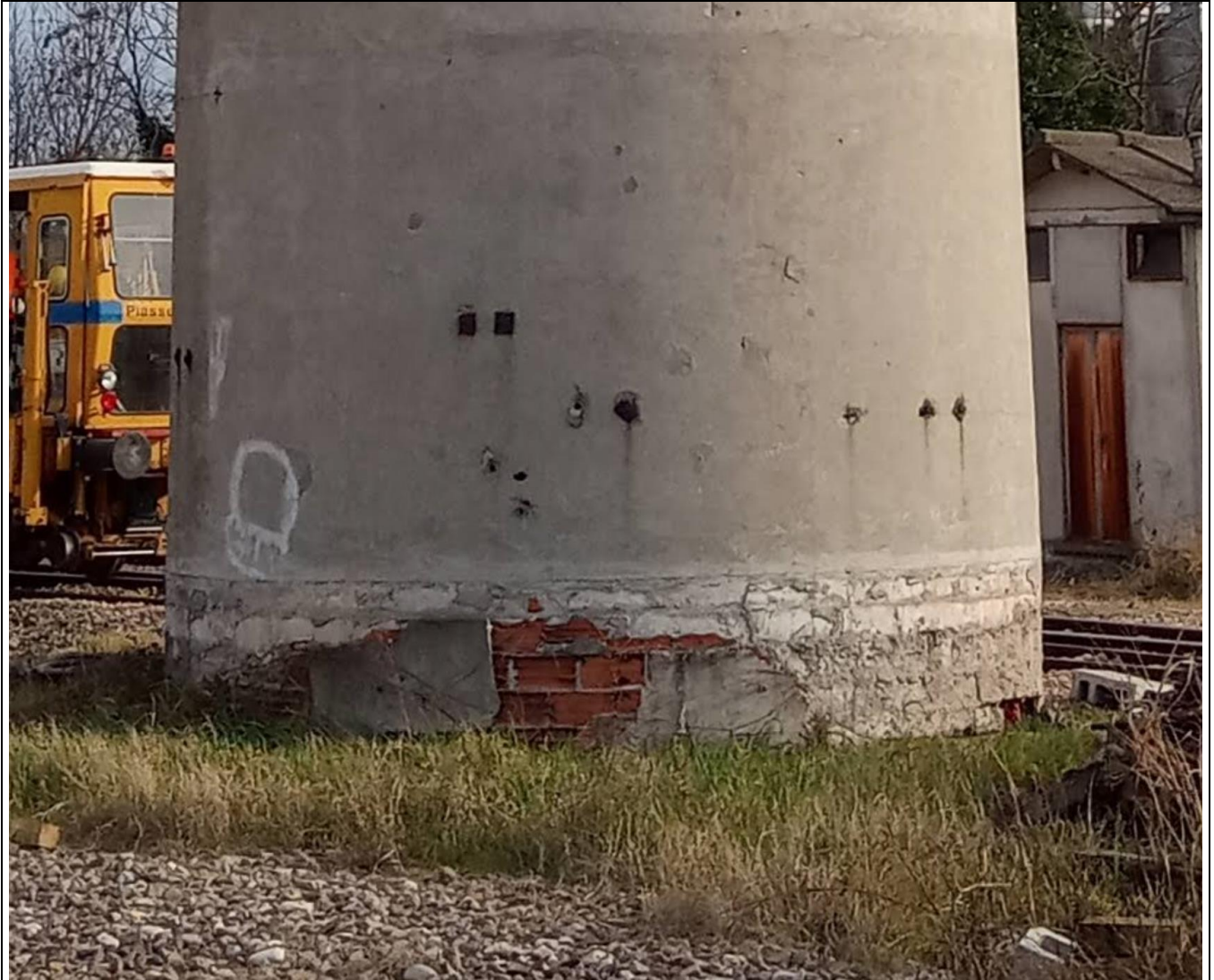
Fig. 8 - Torre piezometrica posta sul lato Ovest dello Scalo – dettaglio della base
