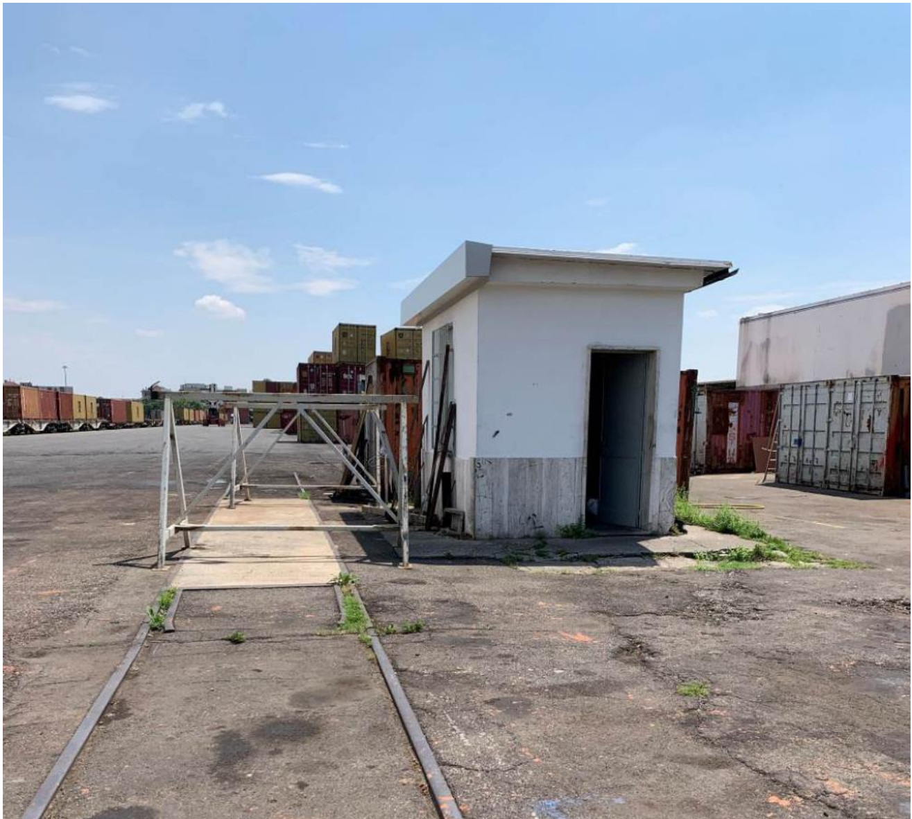
Fig. 16 – Torre piezometrica posta sul lato Est dello Scalo
