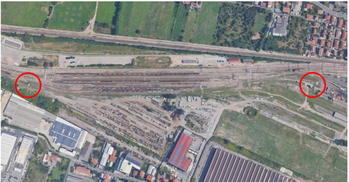
Fig. 1 – Ortofoto con localizzazione dei due serbatoi da demolire
