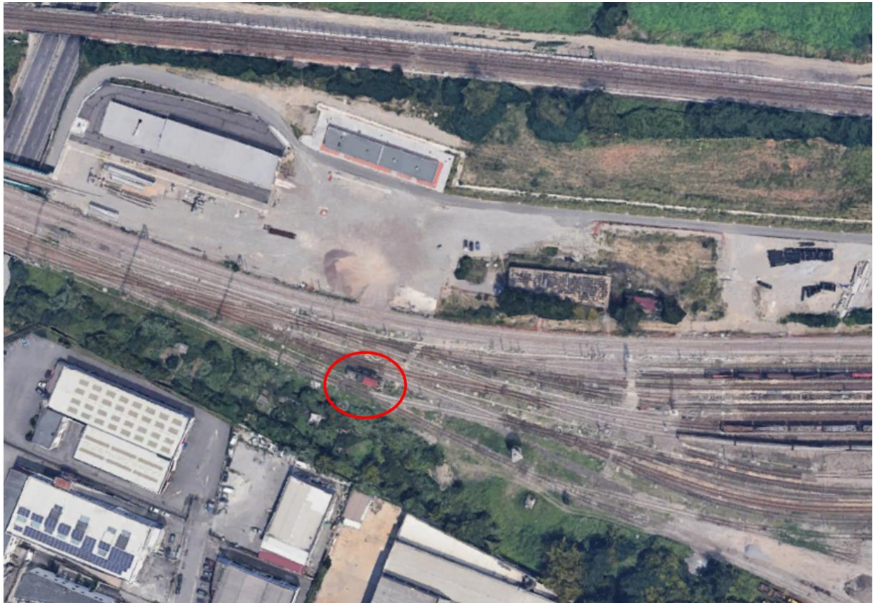
Fig. 9 – Ortofoto con localizzazione della cabina elettrica da demolire
