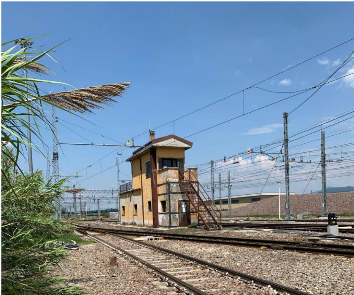
Fig. 12 – Torre piezometrica posta sul lato Est dello Scalo
