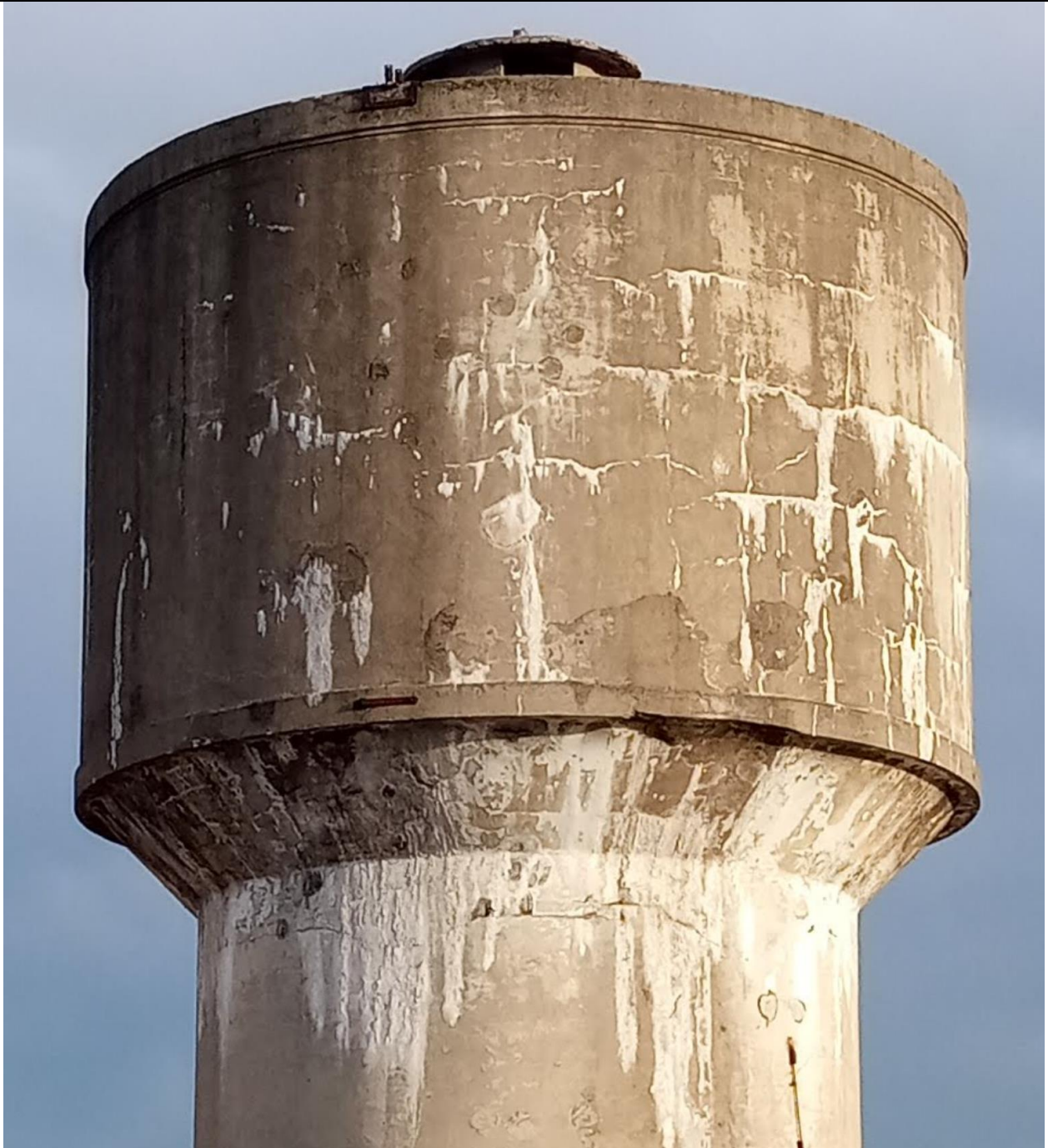
Fig. 4 – Torre piezometrica posta sul lato Est dello Scalo – dettaglio Serbatoio
