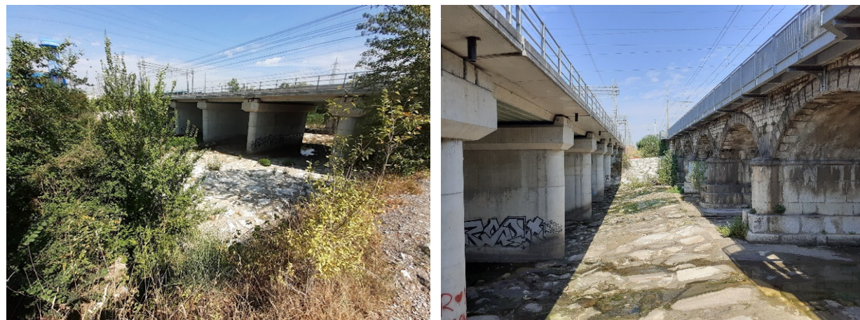
Figura 3-4 Area del fiume Mella in corrispondenza dei viadotti ferroviari esistenti
