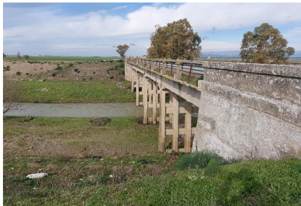
Figura 39: Punto CC2 – Ponte con piloni in c.a. forati a sostegno dello stesso
