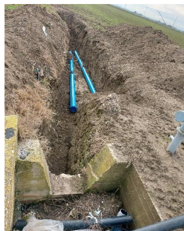
Figura 33: Punto 002 - sottoservizi identificati da tubi con manometro a bordo strada e scavo in terra, probabilmente in corso di realizzazione
