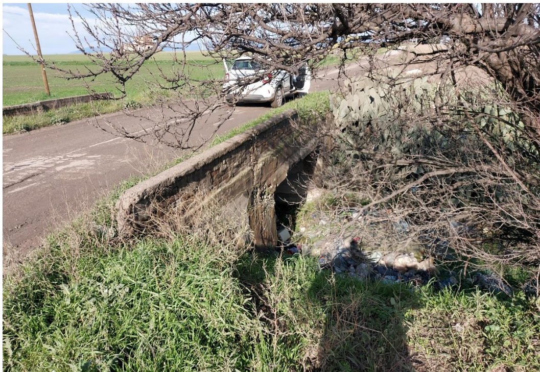
Figura 42: Punto 020 – Ponte con mattoncini in laterizio
