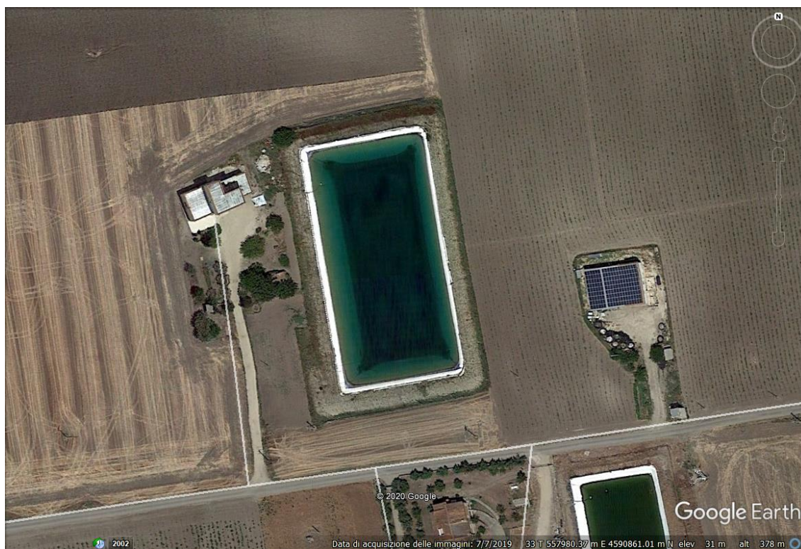
Figura 13: AREA A SUD - Vasca attualmente presente in sito, vista dall'alto, ripresa in fase di sopralluogo col drone
