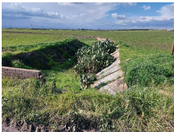
Figura 41: Punto 020 – Canale in direzione est, con lastre in calcestruzzo sulle scarpate ed in direzione ovest con fichi d'india sul letto del canale
