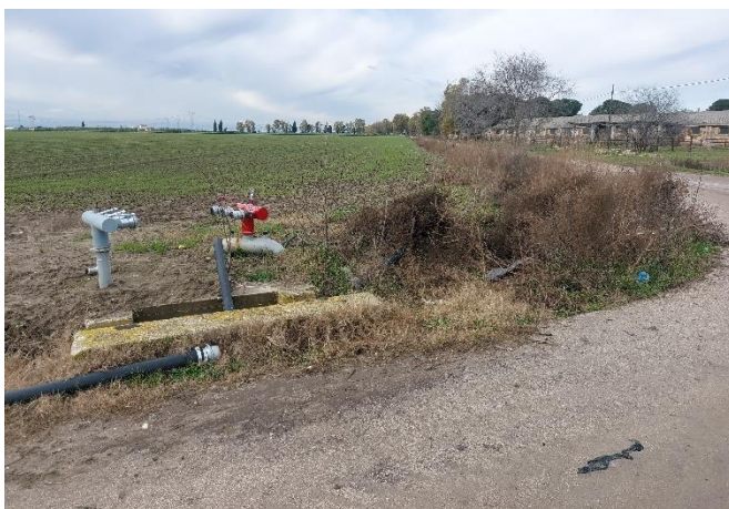
Figura 33: Punto 002 - sottoservizi identificati da tubi con manometro a bordo strada e scavo in terra, probabilmente in corso di realizzazione
