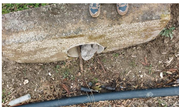
Figura 34: Punto 003 - attraversamento sotto la strada di canale acque meteoriche in calcestruzzo
