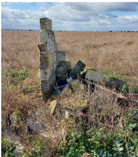
Figura 17: Pozzo in disuso, con contatore presente ormai a terra
