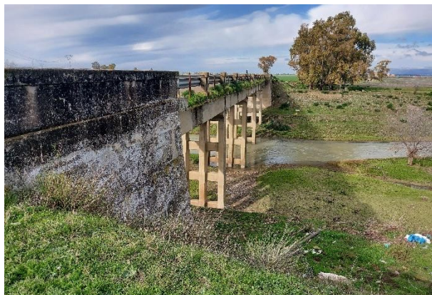
Figura 39: Punto CC2 – Ponte con piloni in c.a. forati a sostegno dello stesso
