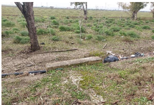
Figura 34: Punto 003 - attraversamento sotto la strada di canale acque meteoriche in calcestruzzo
