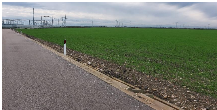
Figura 36: Punto 004 – canali a cielo aperto in calcestruzzo
