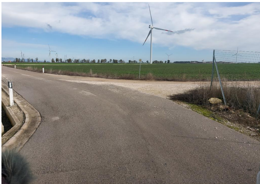
Figura 44: Punto 004 - paletto che informa della linea elettrica interrata in tensione
