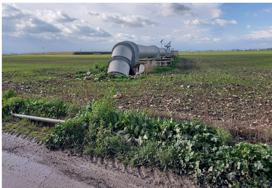
Figura 30: Punto 015 – Tubazione fuoriterra che continua il percorso interrato, con attraversamento stradale
