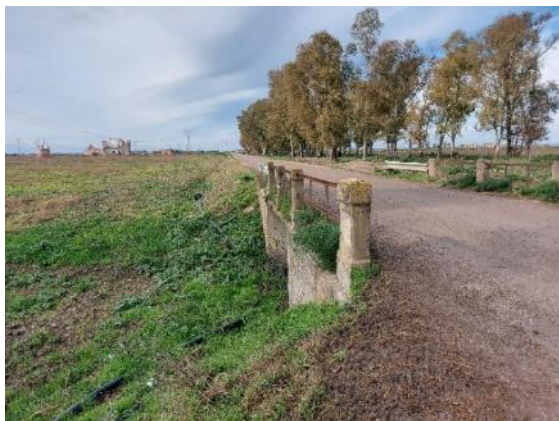
Figura 25 Punto 007: piccolo ponte in c.a. e Punto CC2: ponte con piloni in c.a. forati
