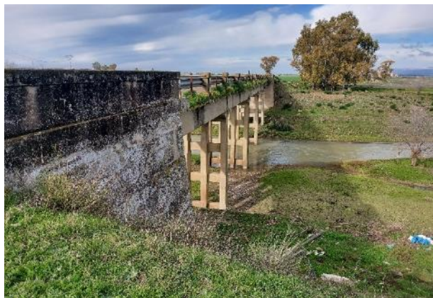
Figura 25 Punto 007: piccolo ponte in c.a. e Punto CC2: ponte con piloni in c.a. forati
