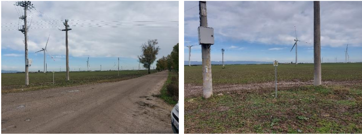
Figura 23: Punto 002 - paletto che informa di un sottoservizio con cavo in tensione a 30 kV
