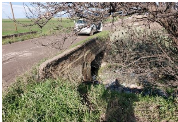
Figura 26: Punto 020 – Ponte con mattoncini in laterizio e Canale in direzione est, con laste in calcestruzzo sulle scarpate
