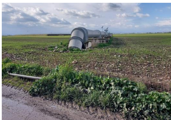
Figura 21: Punto 015 – Tubazione fuoriterra che continua il percorso interrato, con attraversamento stradale
