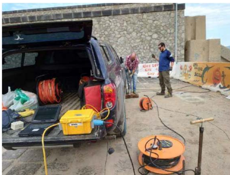
Figura 4-6 Foto ubicazione Down Hole
