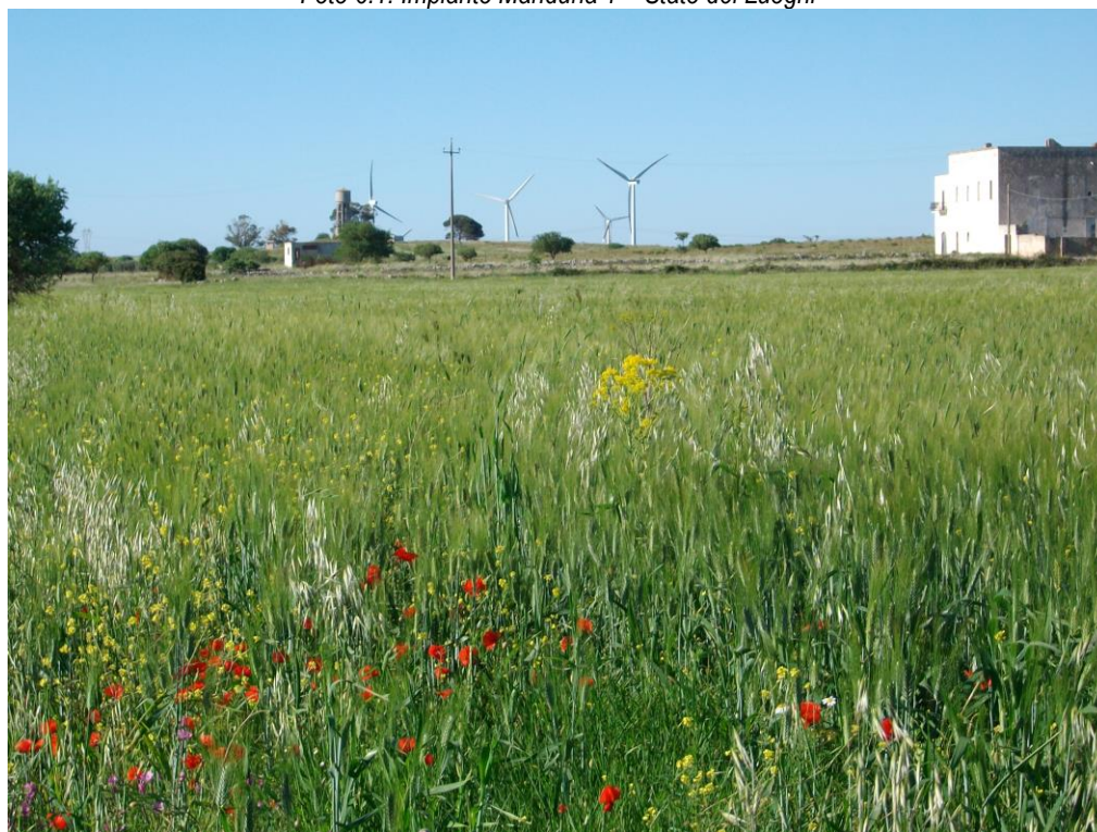
Foto 6.2: Impianto Manduria 1 – Stato dei Luoghi
