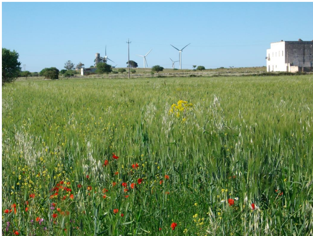
Foto 6.2: Impianto Manduria 1 – Stato dei Luoghi
