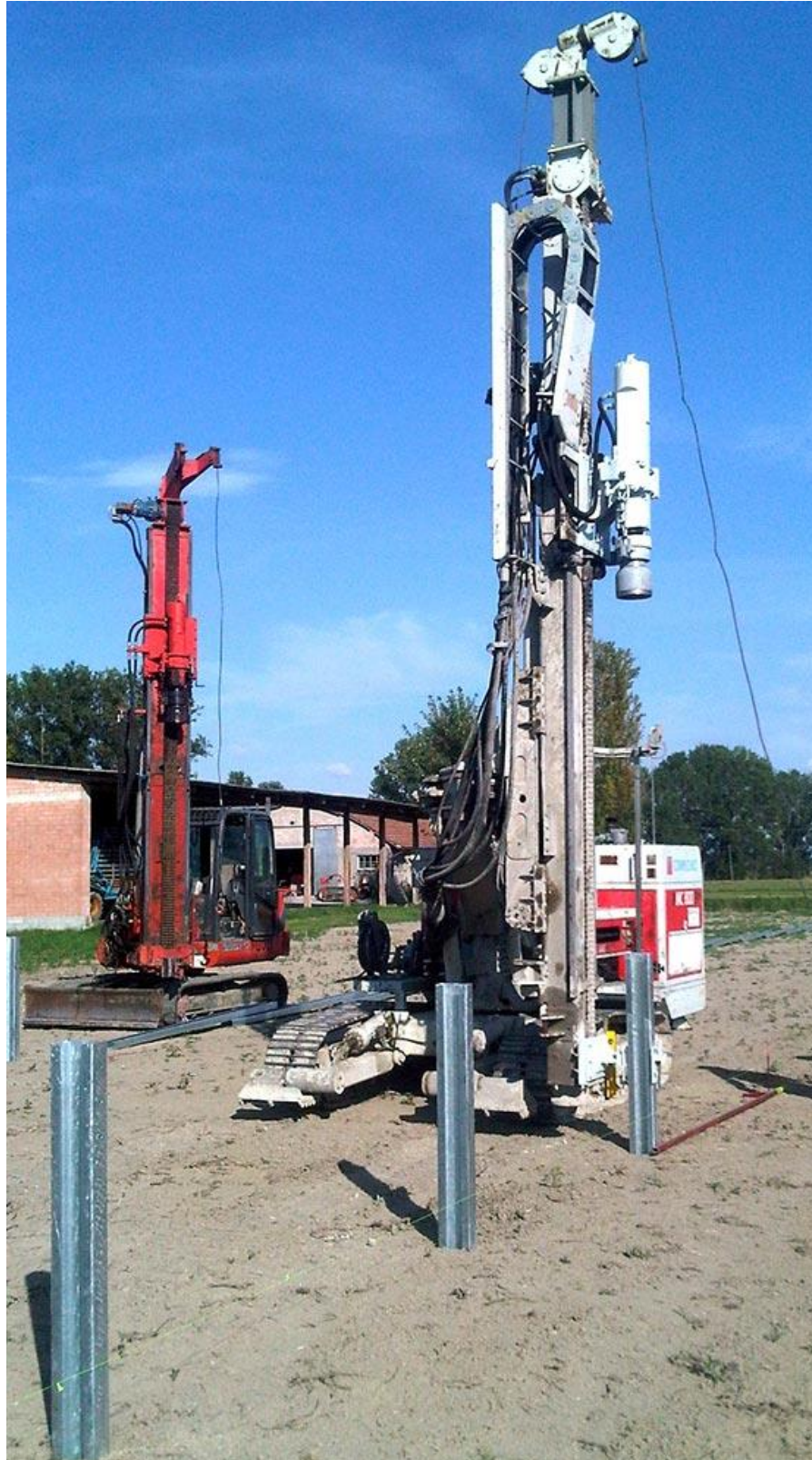
Figura 2.2: Esempio di Macchina Operatrice Battipalo
