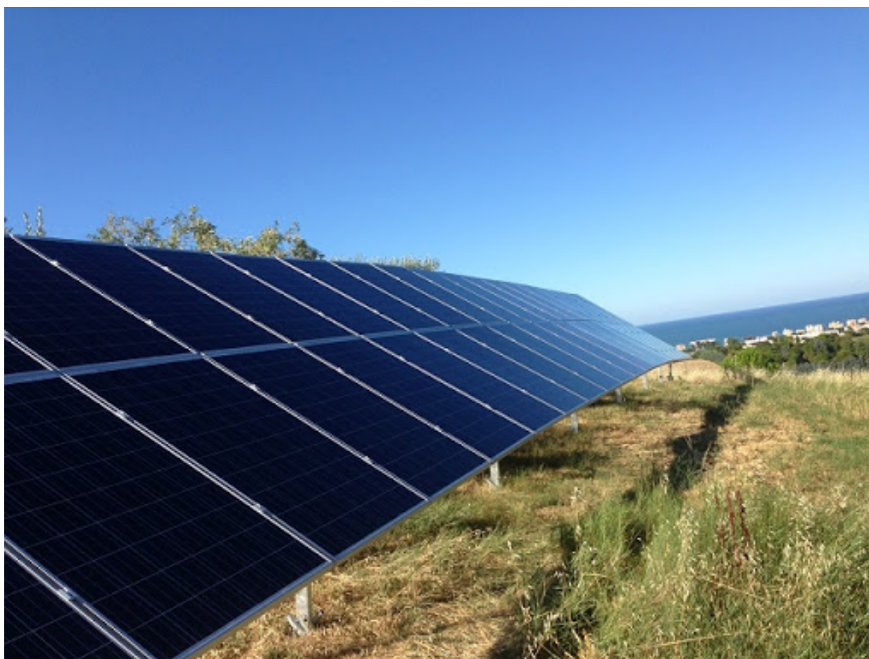
Figura 4.10: Esempio di Struttura di sostegno moduli fotovoltaici
