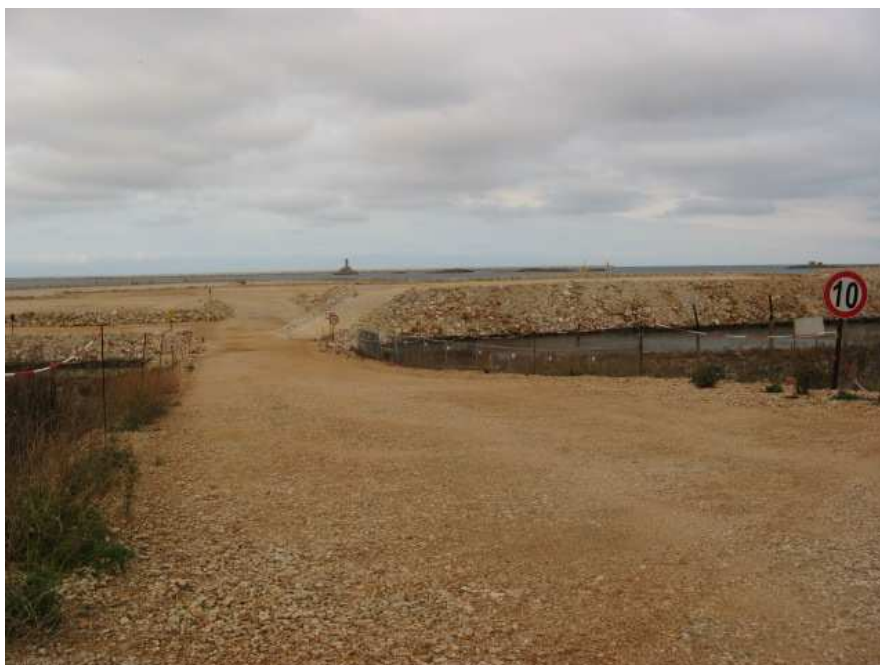
Foto 16: Particolare della zona di cantiere
