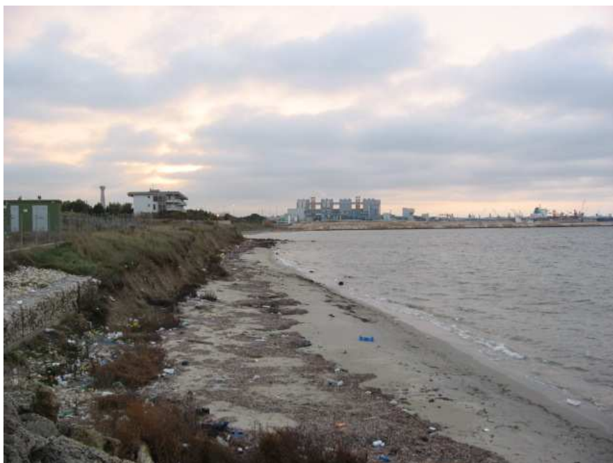
Foto 18: Panoramica della zona prospiciente l'area d'intervento
