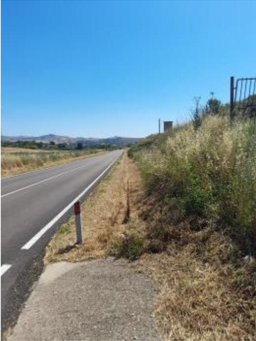
*Figura 3.12 – Tratto di strada provinciale tra La Rimessa e la stazione di trasformazione di Codrongianos soggetta a ruscellamento da parte delle acque provenienti dai versanti*
