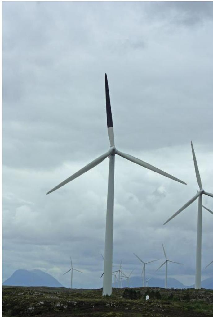
Figura 18 – Turbina con colorazione nera della pala nel parco eolico di Smøla – Norvegia (May. R et al., 2020)
