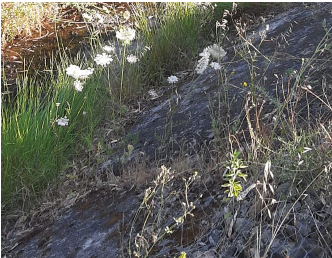
Figura 3-11: Particolare del Rio S'Isca de Arcosu, artificializzato con gabbionate
