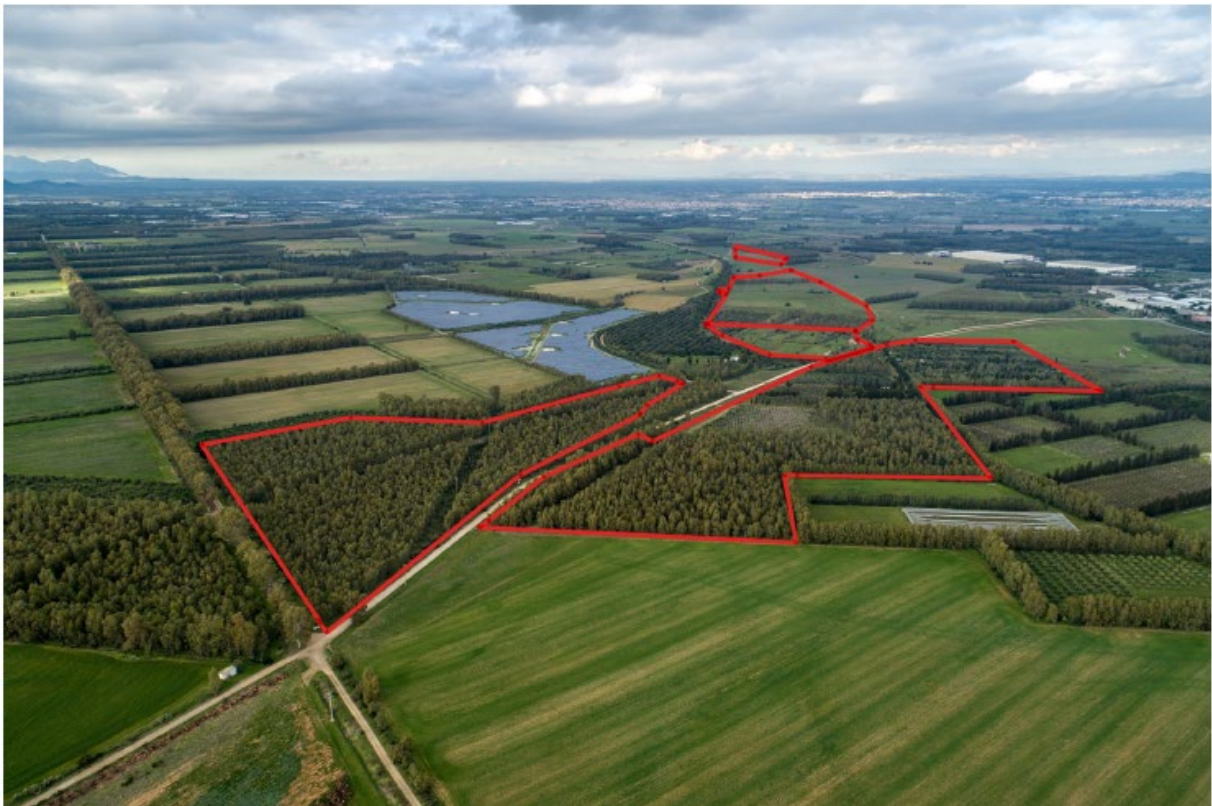
Figura 5-7: Vista aerea dell'area di studio con delimitazione (line rosse) dell'area di progetto
