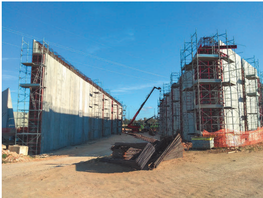
Foto Aree cantiere
