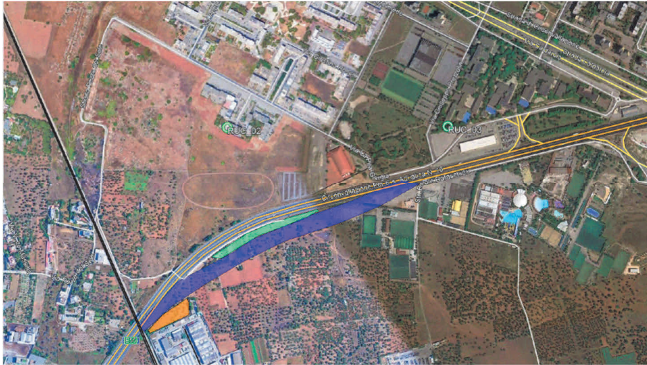
Ubicazione dei punti di monitoraggio (in verde) rispetto alle aree di lavorazione sulla tangenziale S.S. n.16
