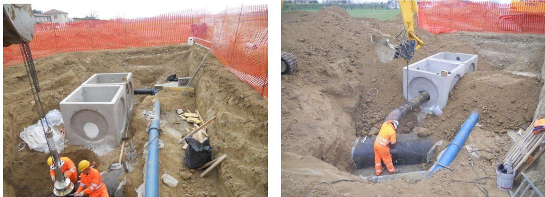
Figura 287: Opera di interconnessione con pozzetto di intercettazione
