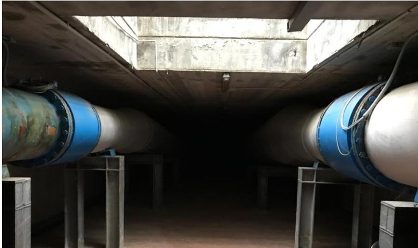
*Figura 243: Adduttrici principali dell'AdR correnti nel cunicolo tecnico*
