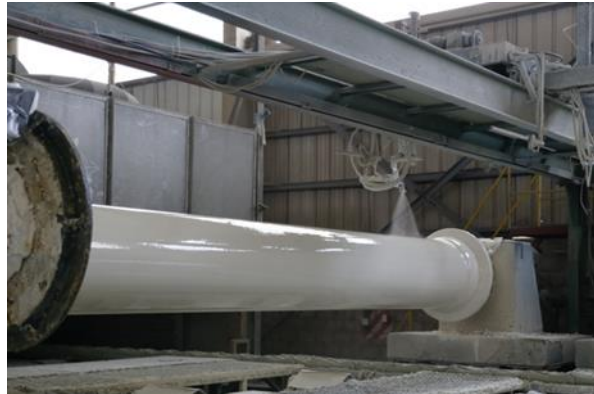
Figura 4 - rivestimento esterno applicato per spruzzatura
