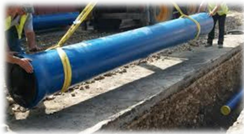
Esempio di posa condotte in corrispondenza di sede stradale
