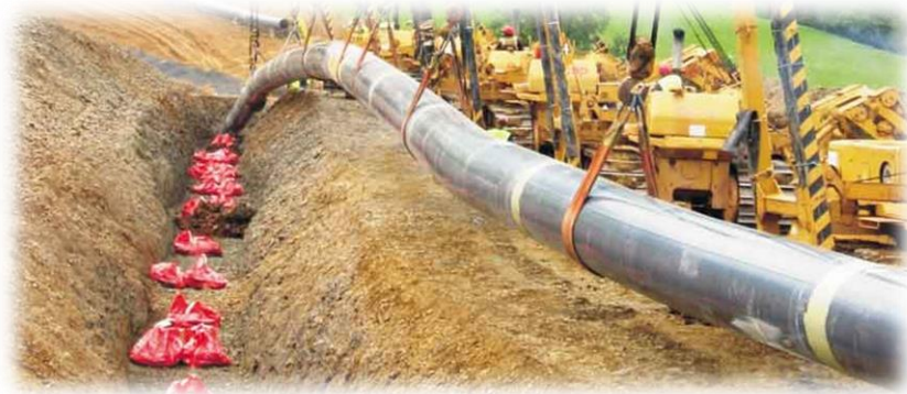
Esempio di posa condotte in corrispondenza di terreno agricolo
