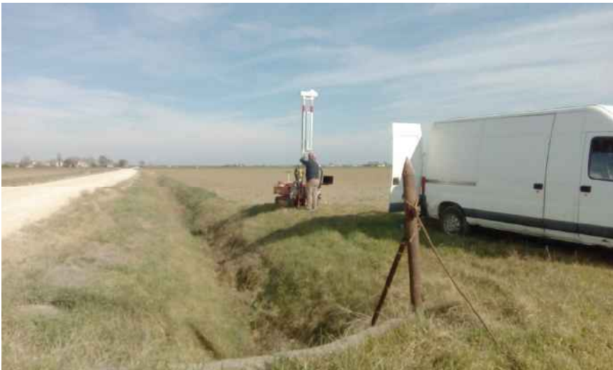
P3 via Fosso Nuovo Ravenna
