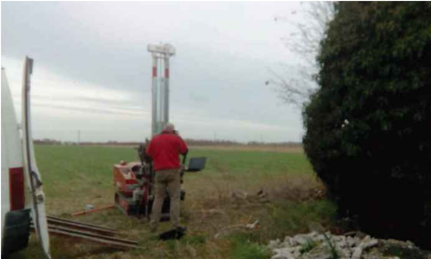
P7 via Fossa Ravenna
