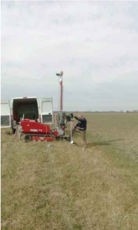
P4 via Fosso Nuovo Ravenna
