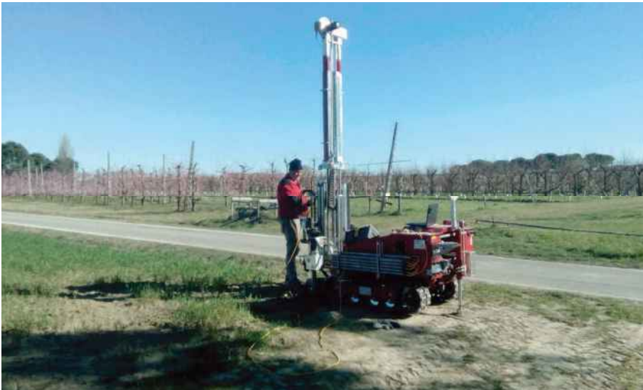
P19 via del Fiume in Ronta Cesena
