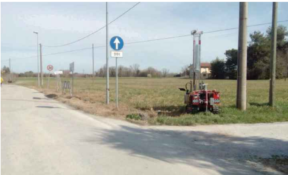
P9 Via Palazzone Mensa Ravenna
