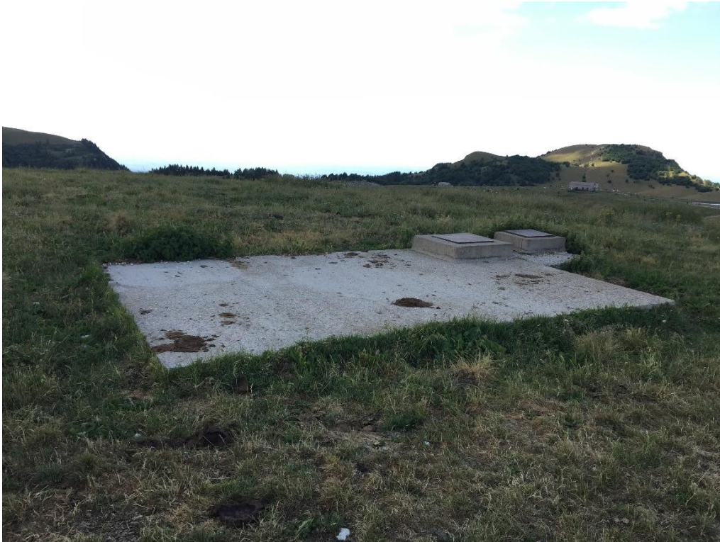
Foto 22: Serbatoio interrato in disuso.
