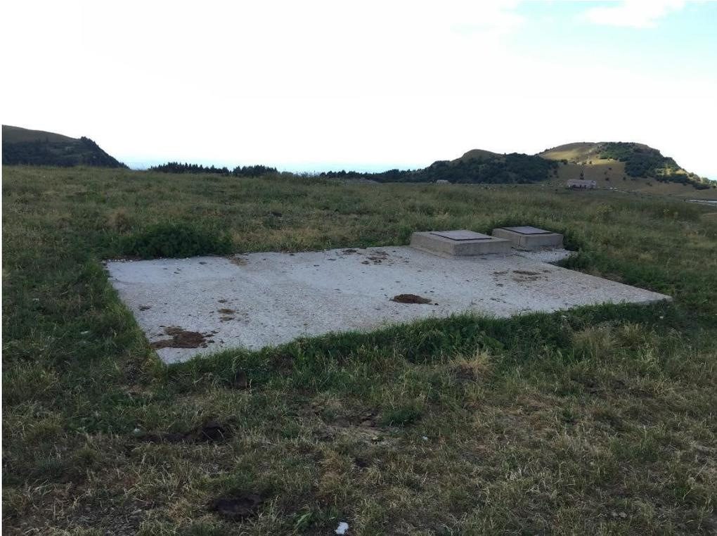
Foto 22: Serbatoio interrato in disuso.
