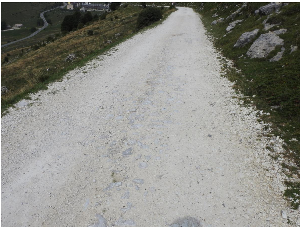
Fig. 32: strada militare verso Malga Malera Bassa, particolare dei resti della selciature del piano stradale (MA04)
