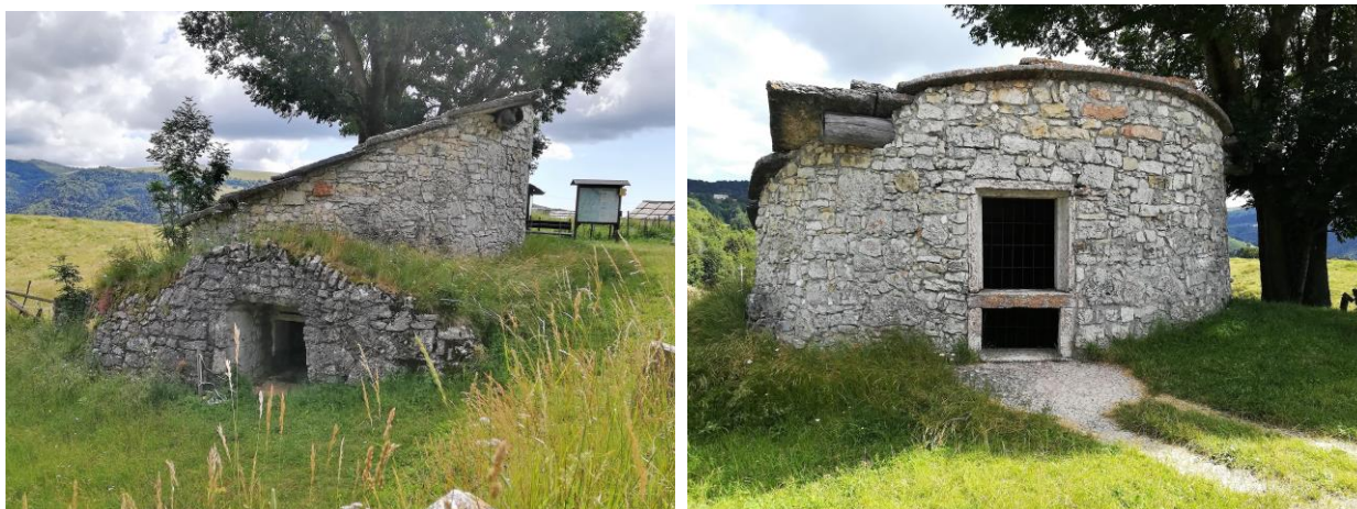
Viste della “Giassara di Grietz” localizzata nel contesto di progetto
