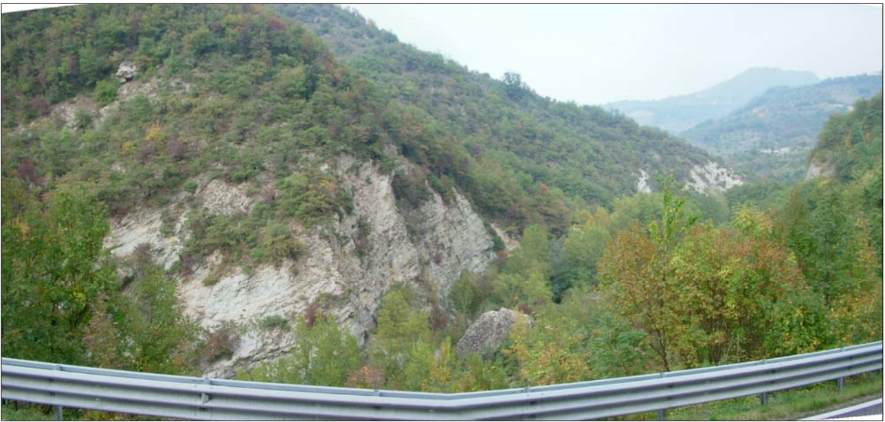
Foto 16 Marne con Cerroigna passanti a Bisciaro (lato Nord del F.Tronto)
