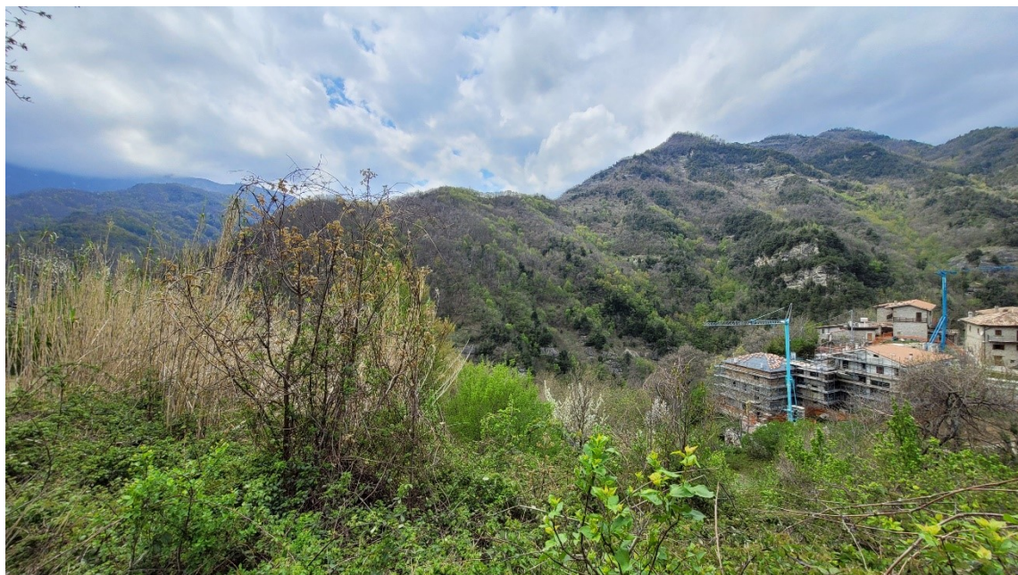
Figura 3 - Vista del versante del Settore centrale.
