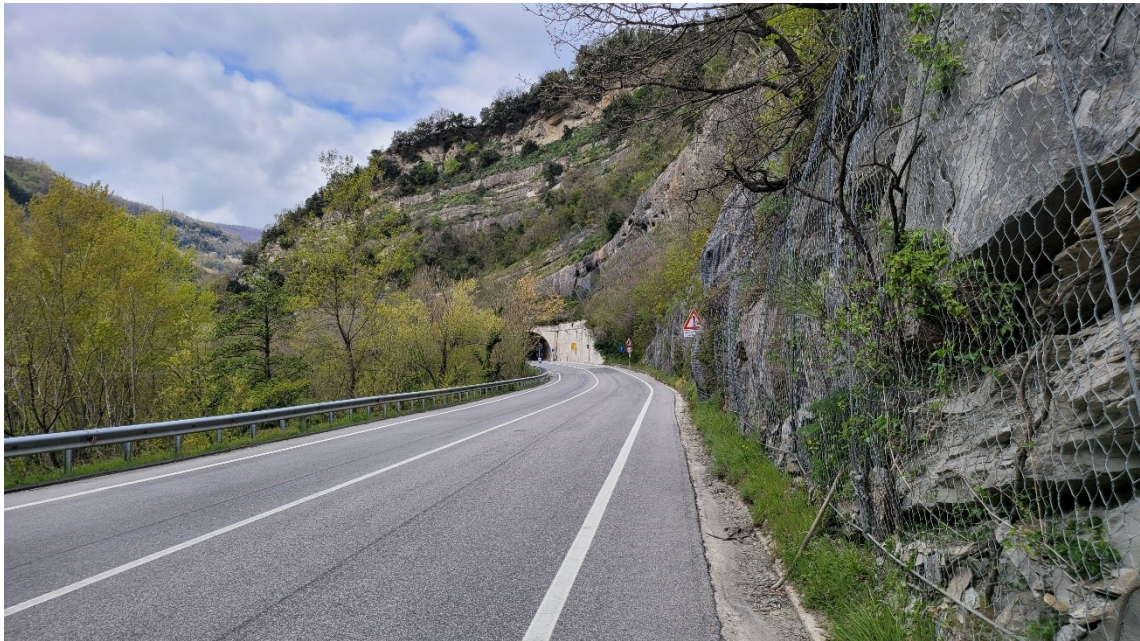
Figura 2 - Vista della parete bassa del Settore Ovest in corrispondenza dell'inizio del Lotto 2.
