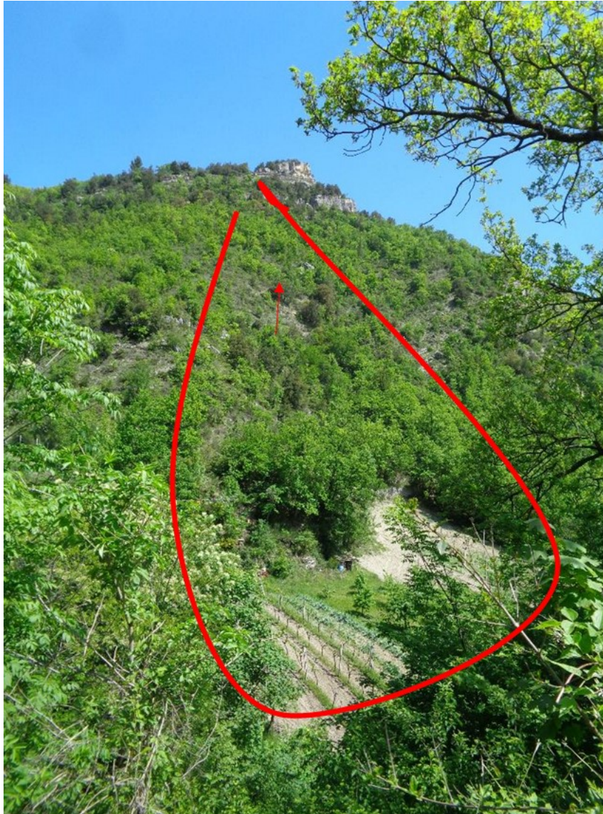
Figura 28 - Area delle più probabili traiettorie che non dovrebbero raggiungere la zona di imbocco in quanto un canale abbastanza definito le confina. La freccia indica un blocco di volume stimato di circa 1\,000 \div 1\,300\text{ m}^3 . I blocchi in questo settore del pendio non sono molti e questo è quello di maggiori dimensioni.
