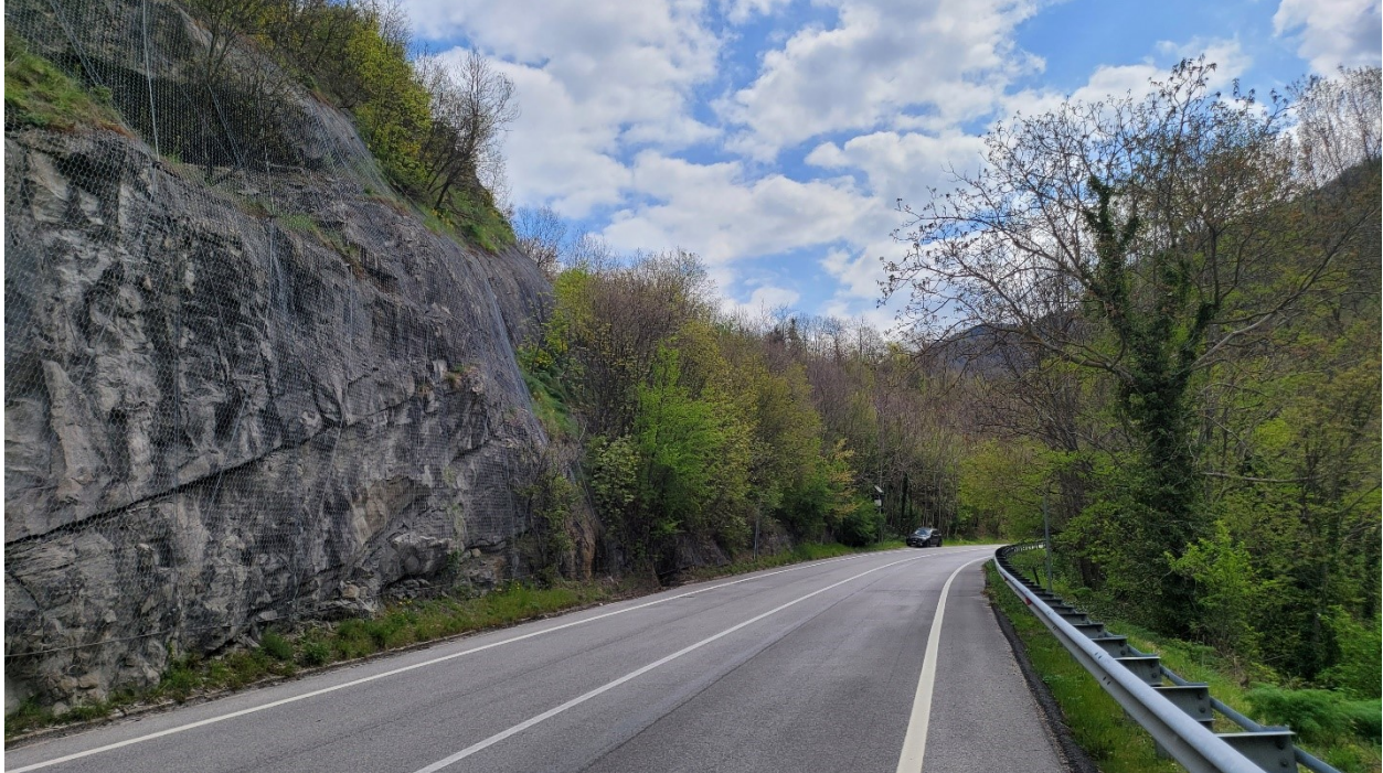
Figura 13 - Ripresa fotografica della S.S.4 nel tratto dove è previsto l'ingresso della galleria "Favalanciata".
