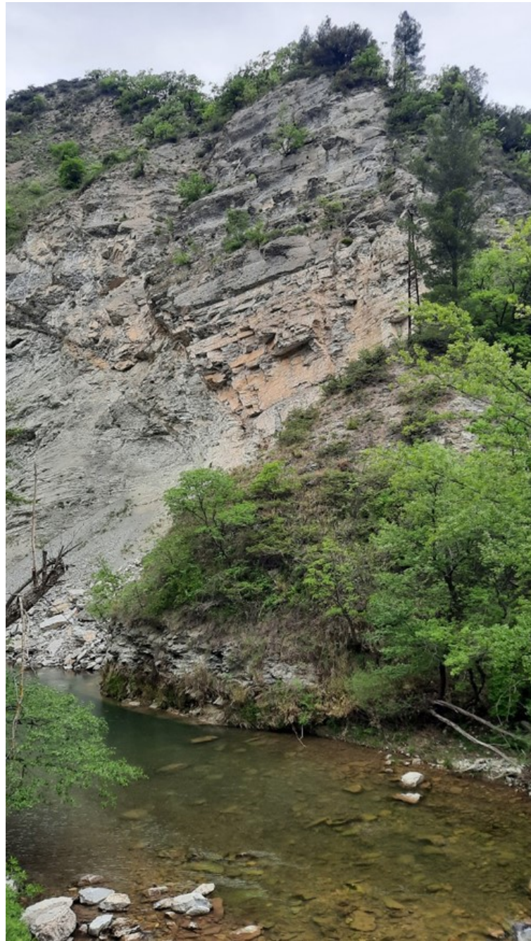
Figura 24 - Ripresa fotografica della scarpata rocciosa in prossimità dell'impianto termale.
