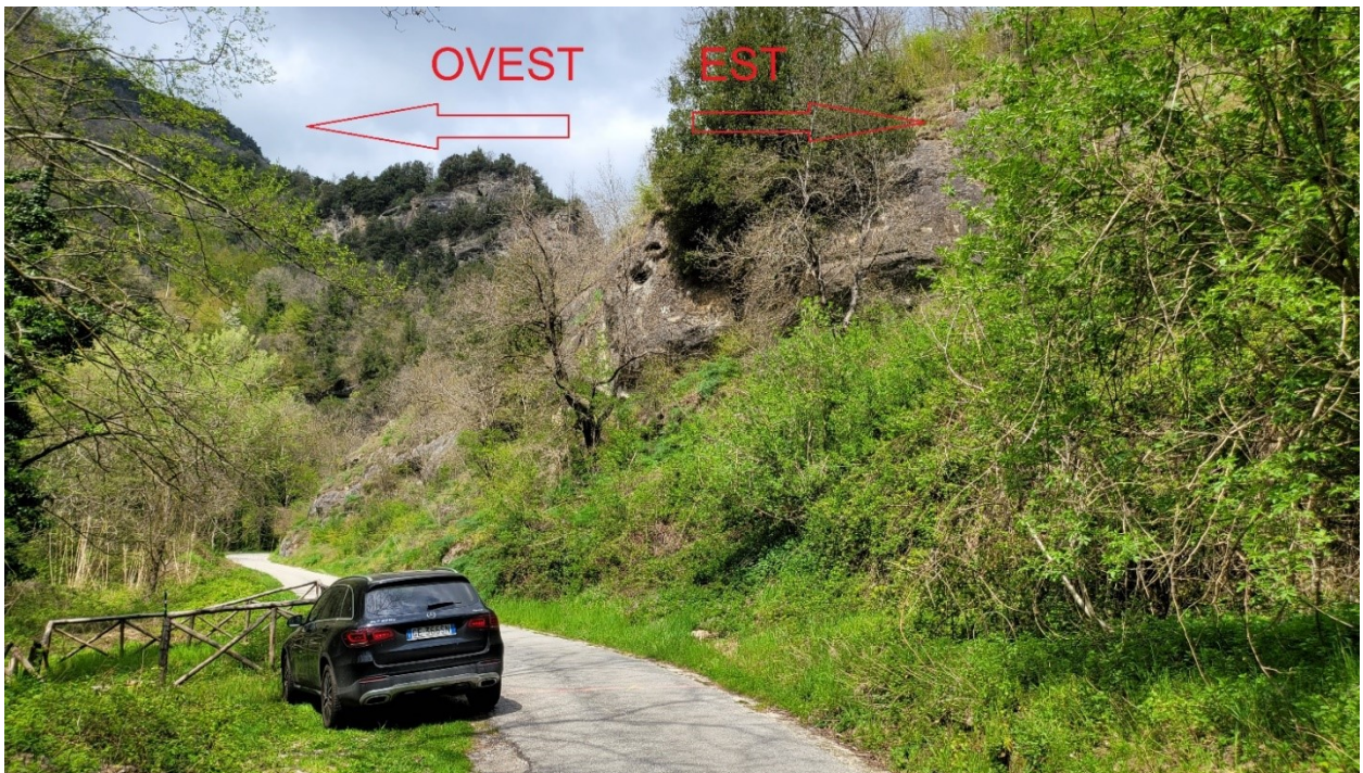
Figura 20 - Ripresa fotografica della valle del Rio di Novele nella zona di realizzazione del viadotto.
