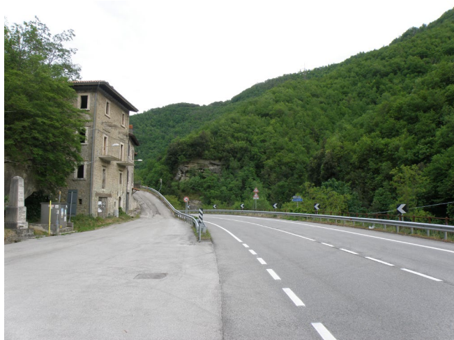
Figura 1.1: SS4 Salaria e viabilità di accesso all'abitato di Favalanziata
