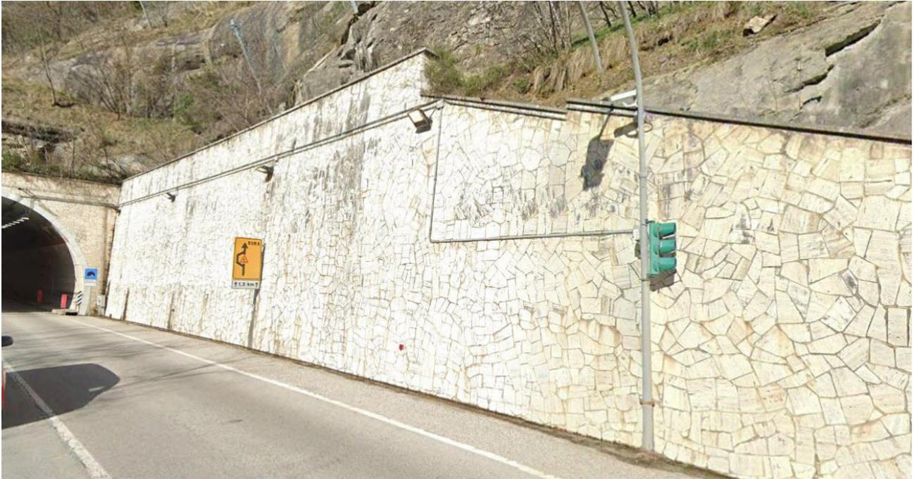
Figura 2.42: Rivestimento muro di contenimento - uscita galleria Valgarizia
