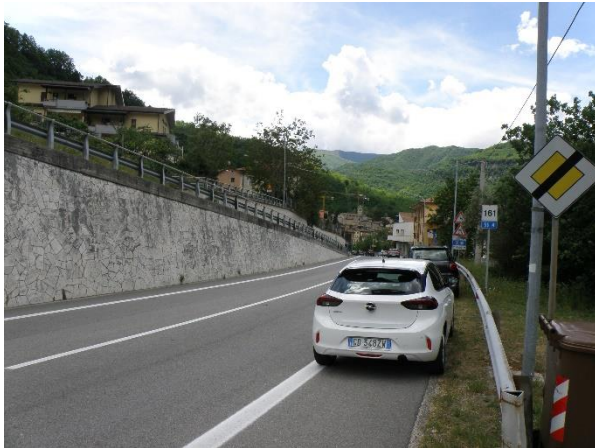
Figura 1.4: SS4 al km 161+000
