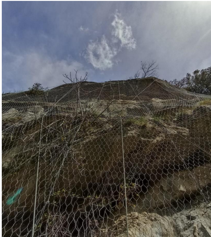
Figura 3-29 - Parete rocciosa composta da banchi di arenarie, con sistema di reti paramassi, situata in prossimità della Salaria, nel tratto che da Quintodecimo arriva sino a Favallanciata
