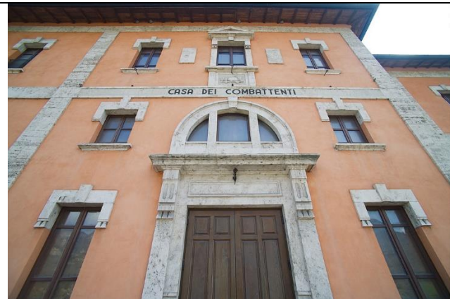
Ex teatro comunale – Casa dei Combattenti
