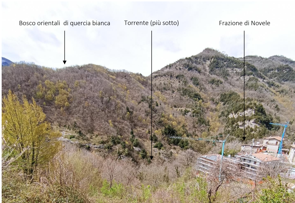
Figura 3-17 - Vista da sopra il futuro cavalcavia
