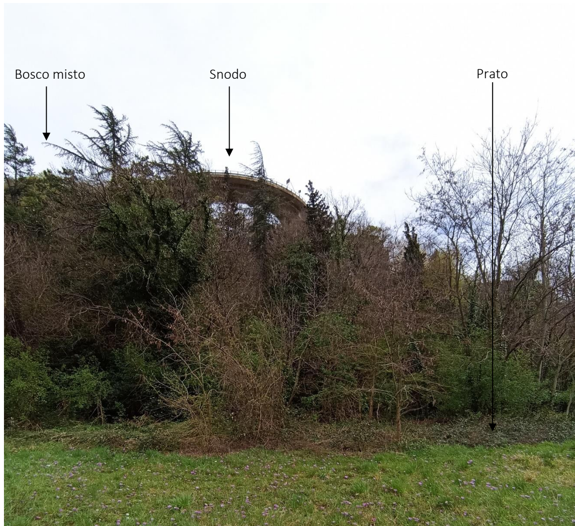
Figura 3-15 - Vista da sotto il futuro collegamento con l'infrastruttura di progetto
