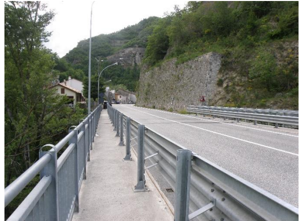
Figura 1.5: SS4 Viadotto Quintodecimo al km 158+000
