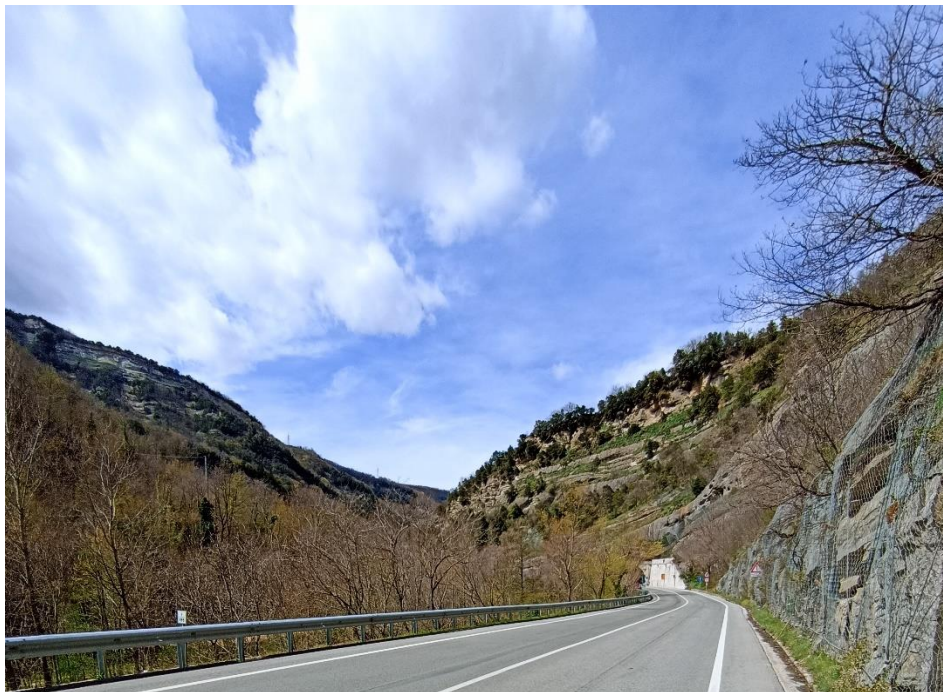
Figura 3-28 - Strada Statale 4 Salaria, inserita tra il fiume Tronto (che nella foto in oggetto scorre sulla sinistra) e le pareti rocciose costituite da banchi di arenarie (a destra). La SS4 segue l'andamento tortuoso della valle del fiume Tronto.
