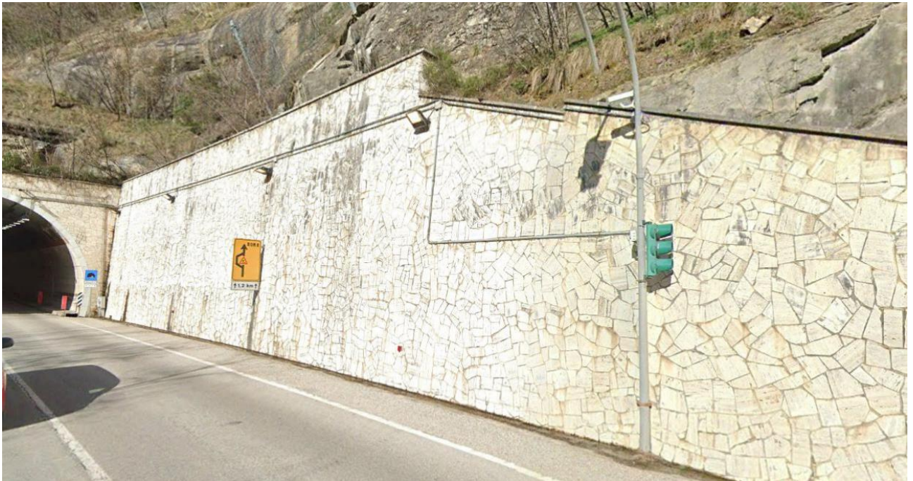
Figura 4-21: Rivestimento muro di contenimento - uscita galleria Valgarizia
