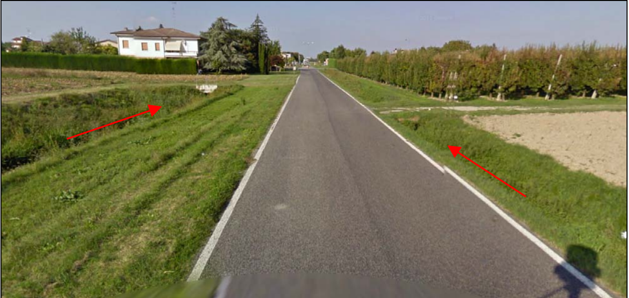
FIGURA 8.2 – IMMAGINE DELLA STRADA ALLA STATO ATTUALE CON IL FOSSO PRIVATO (IN DESTRA) E LO SCALO SALIONE (IN SINISTRA) ESISTENTI
