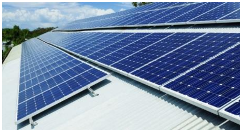
Figura 7-1 - Esempio di impianto fotovoltaico aderente la falda
