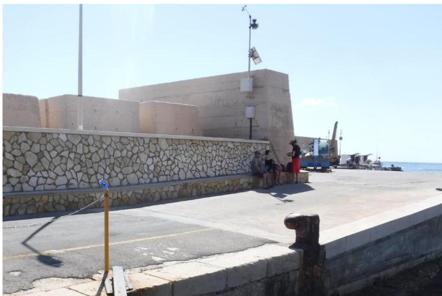
Figura 10 - Inizio tratto muro paraonde a quota + 6,30 s.l.m. (tratto non rivestito fino alla testata)
