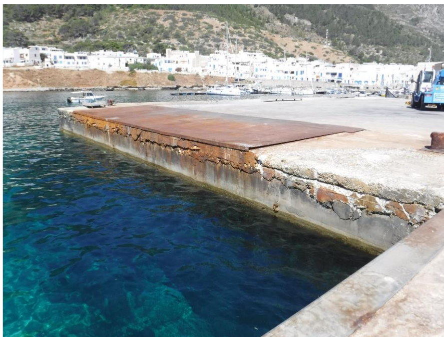
Figura 7 - Banchina per attracco navi traghetto (attracco di poppa) e sullo sfondo pontile galleggiante per imbarcazioni da diporto
