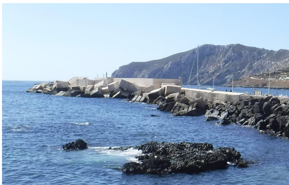
Figura 13 - Foto dello stato attuale nel tratto di mantellata da ricaricare
