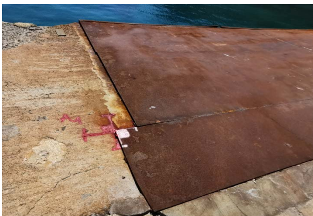
Figura 4.1 b – Alcuni Punti topografici d'appoggio fotogrammetrico utilizzati
