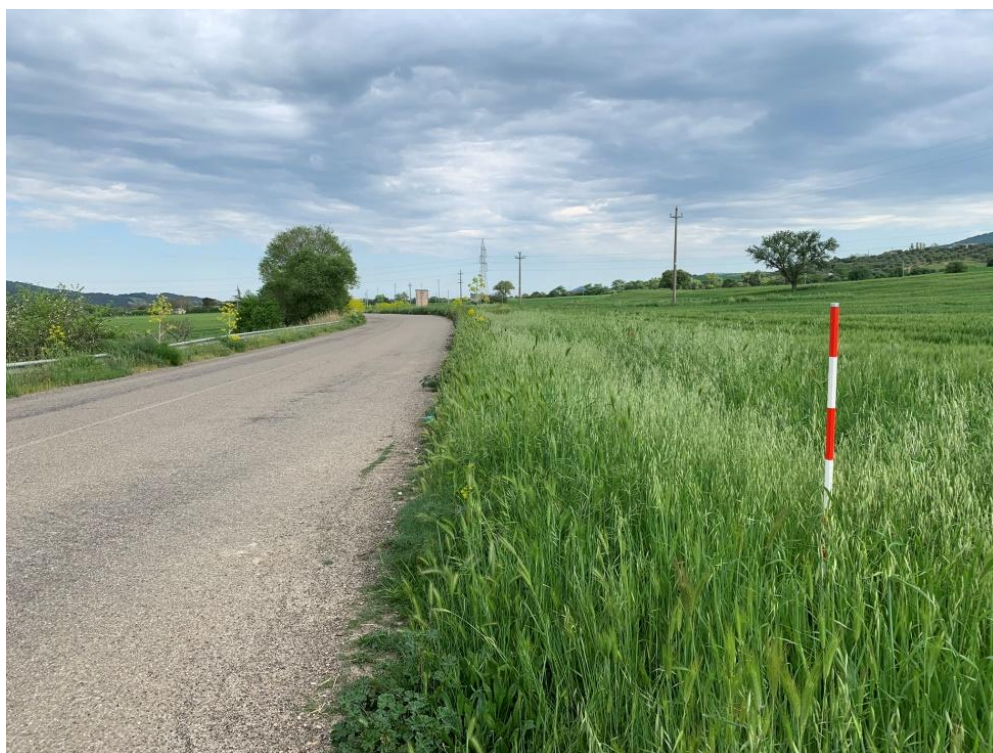
Foto 03: UR 1, area SOTTOSTAZIONE/CAVIDOTTO.
