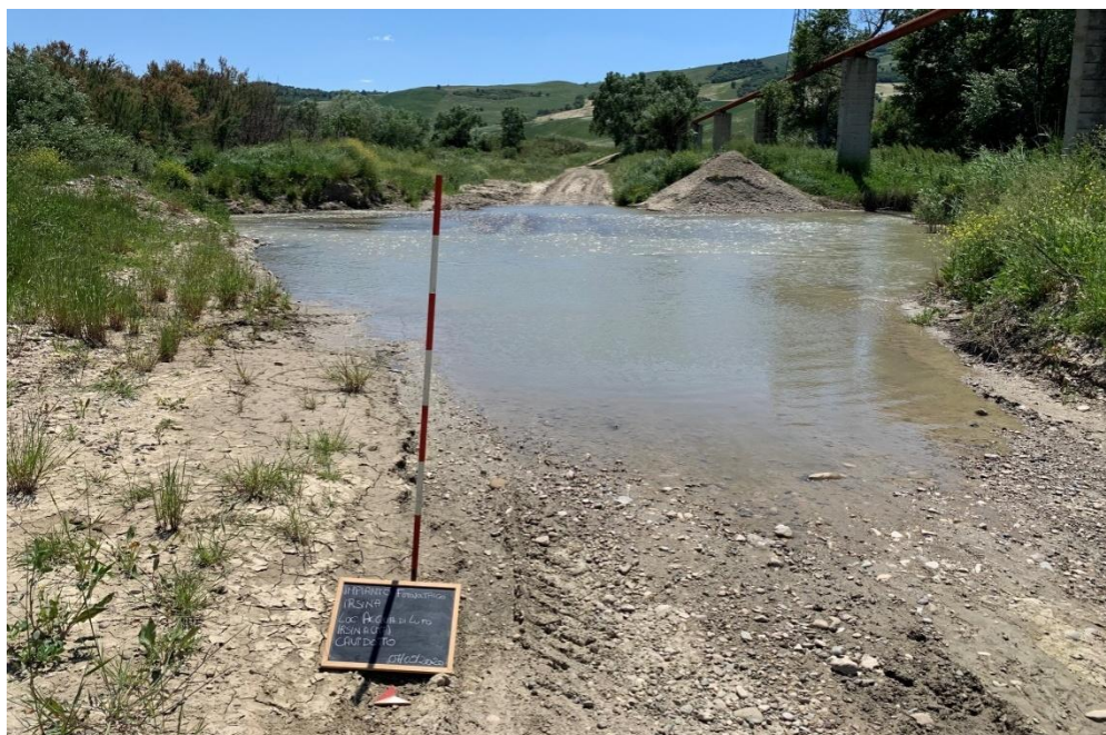
Foto 18: UR 2, CAVIDOTTO, INTERRUZIONE.IRSINA.
