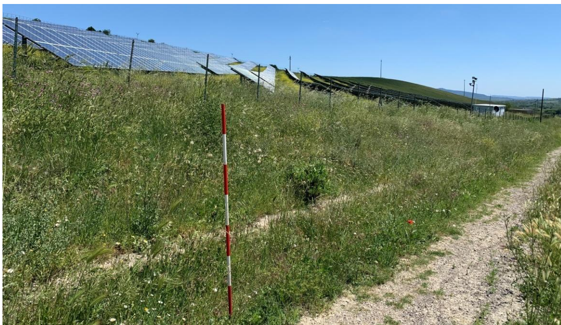
Foto 29: UR 3, area IMPIANTO.
