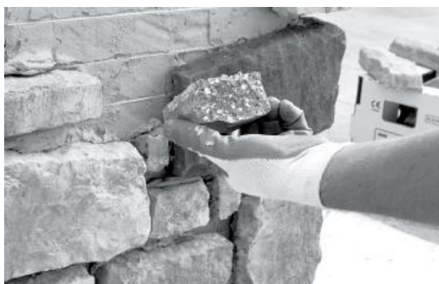
Figura 70 – Rivestimento muro realizzato con singole pietre affiancate.
