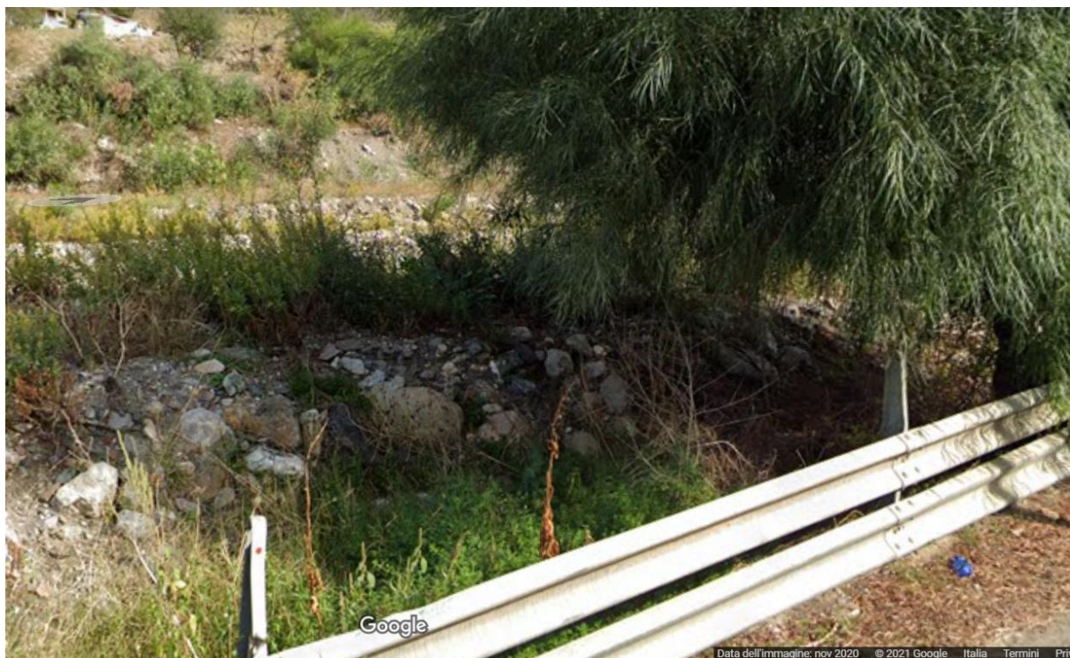
Figura 5 – Fotografia scattata in corrispondenza del segnaposto VI03-1.
