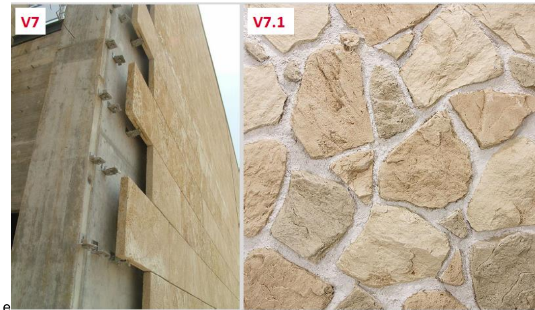
Figura 72 – Confronto tra il tipo “V7” (applicazione su parete areata) e il “V7.1”
