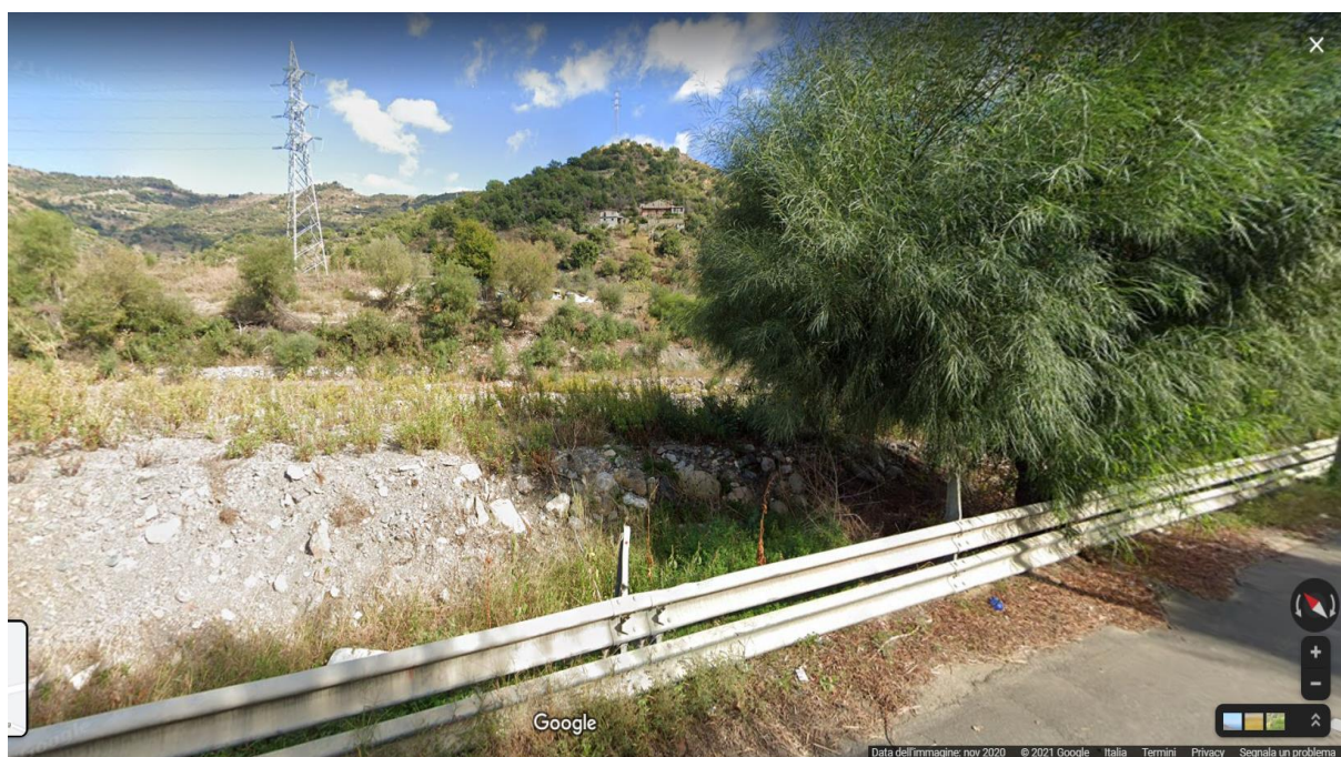
Figura 4 – Fotografia scattata in corrispondenza del segnaposto VI03-1.
