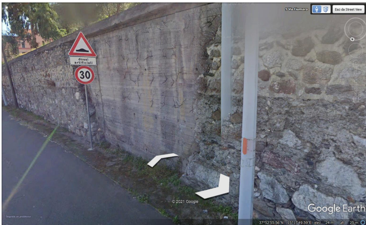
Figura 12 – Fotografia scattata in corrispondenza del segnaposto VI03-4.
