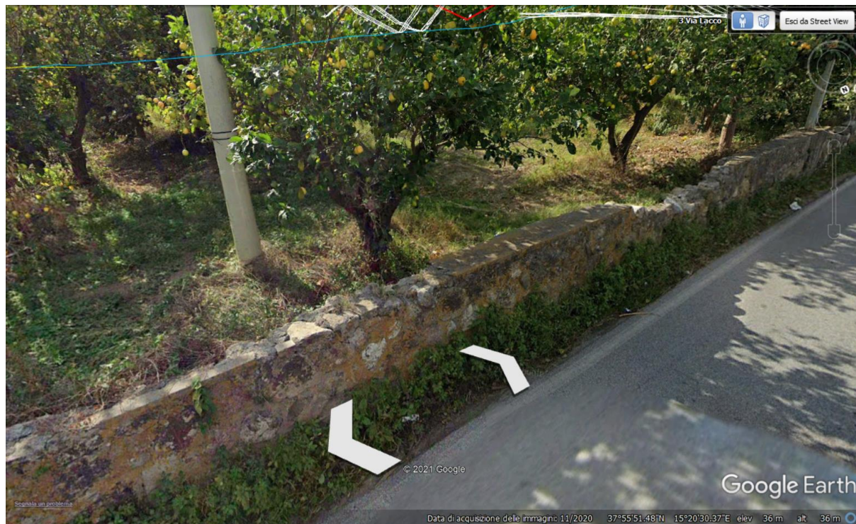
Figura 27 – Fotografia scattata in corrispondenza del segnaposto VI05-4.
