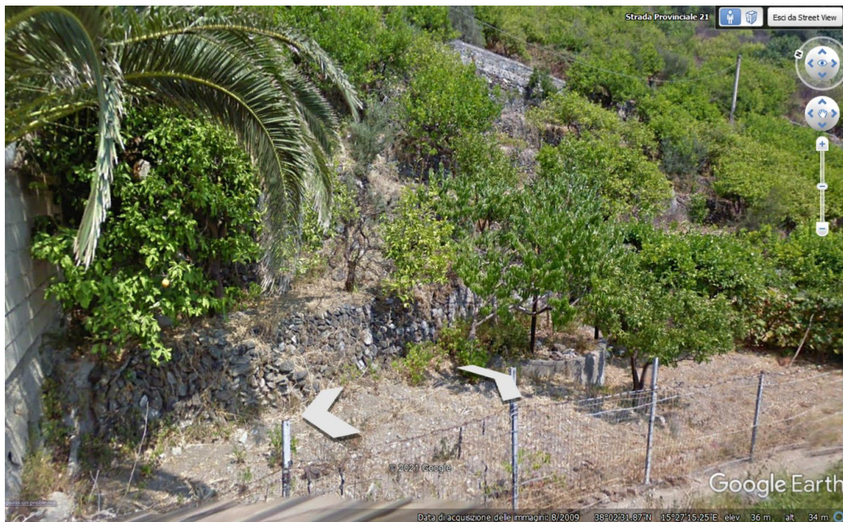
Figura 62 – Fotografia scattata in corrispondenza del segnaposto VI09-4.
