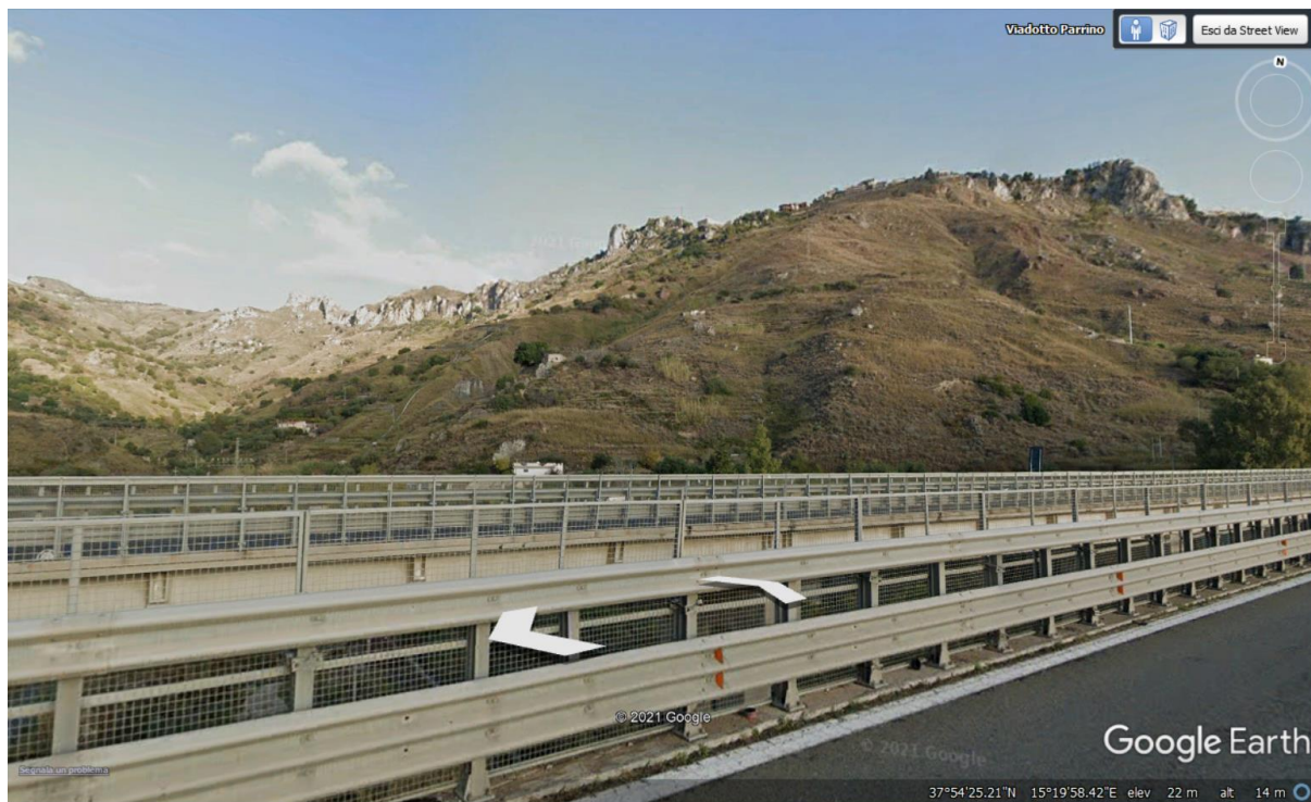
Figura 16 – Fotografia scattata in corrispondenza del segnaposto VI04-1.
