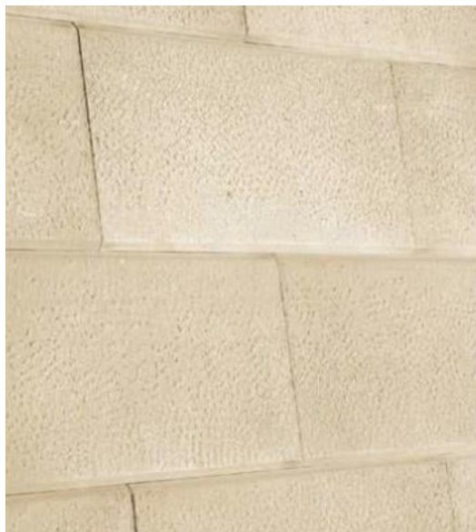
Figura 73 – Finitura tipo bocciardata del tipo “V7”
