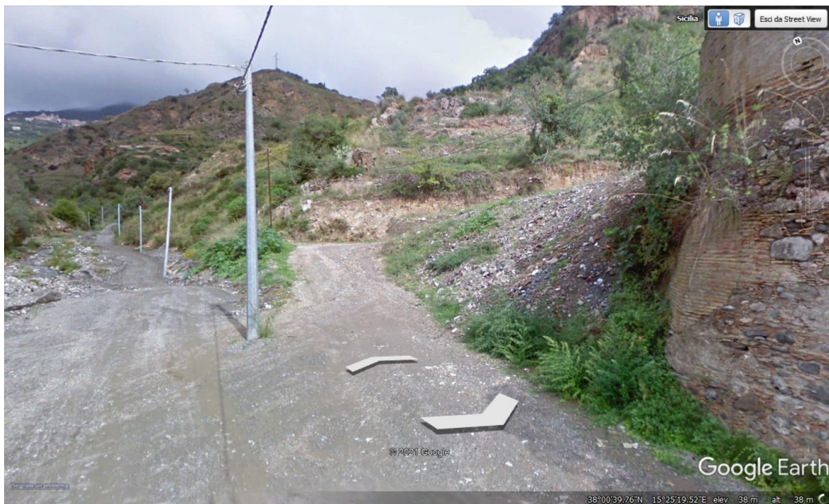
Figura 49 – Fotografia scattata in corrispondenza del segnaposto VI08-1.
