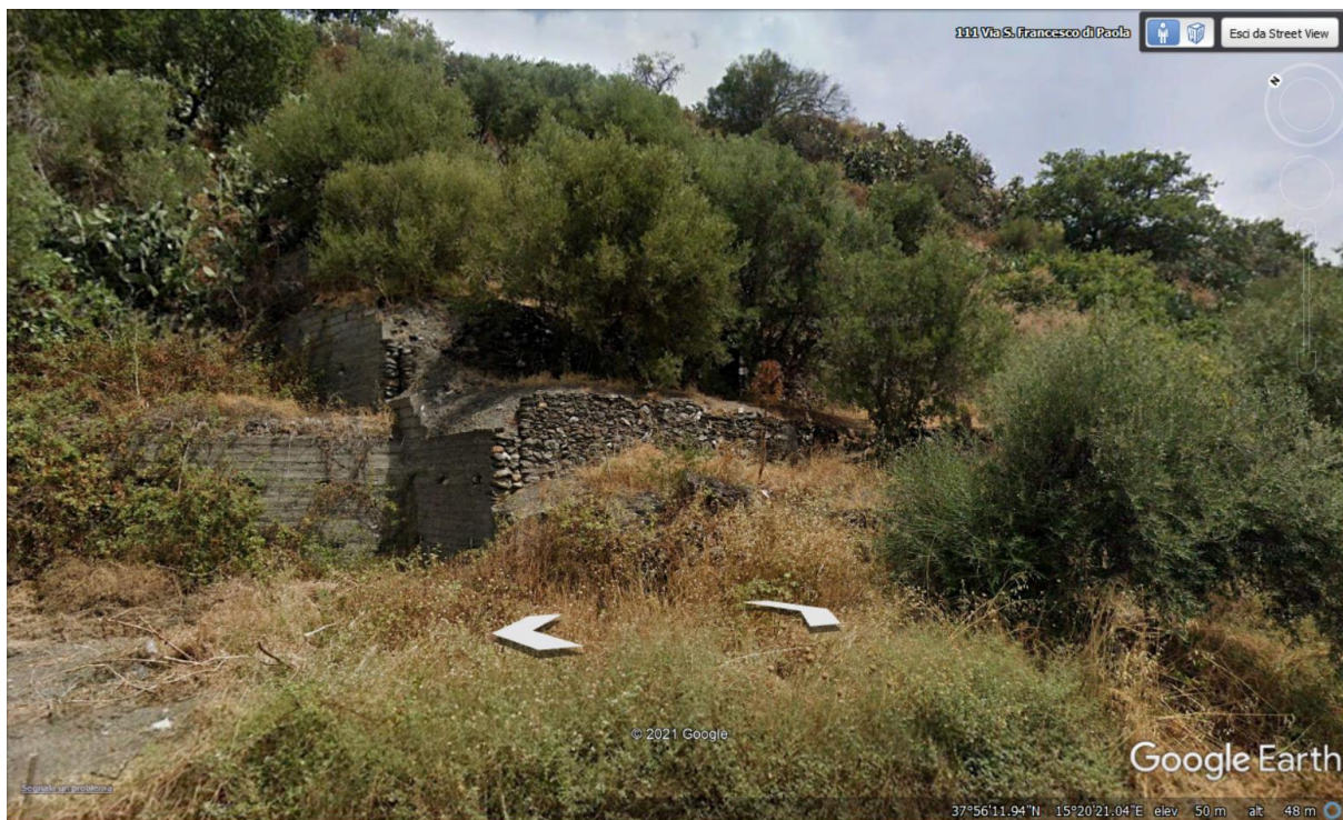
Figura 22 – Fotografia scattata in corrispondenza del segnaposto VI05-1.
