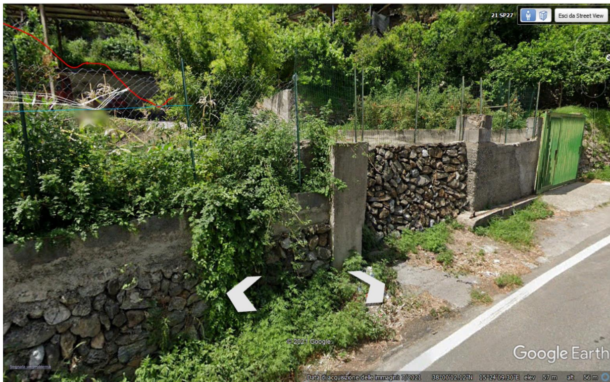
Figura 37 – Fotografia scattata in corrispondenza del segnaposto VI06-4.
