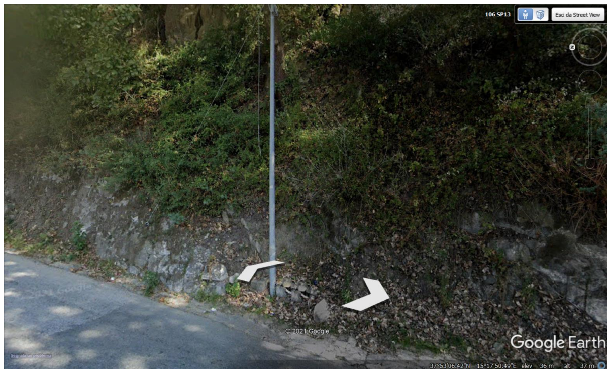
Figura 10 – Fotografia scattata in corrispondenza del segnaposto VI03-3.
