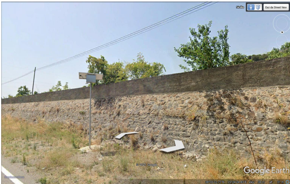
Figura 35 – Fotografia scattata in corrispondenza del segnaposto VI06.2.
