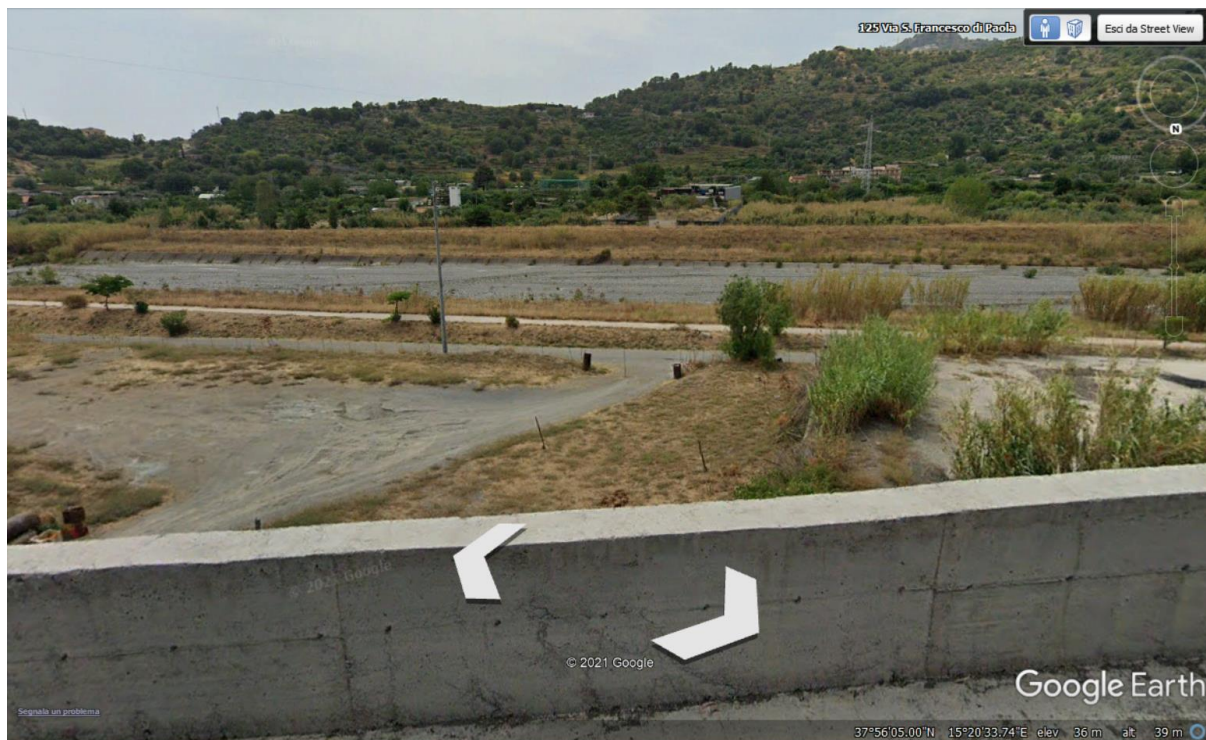
Figura 25 – Fotografia scattata in corrispondenza del segnaposto VI05-2.
