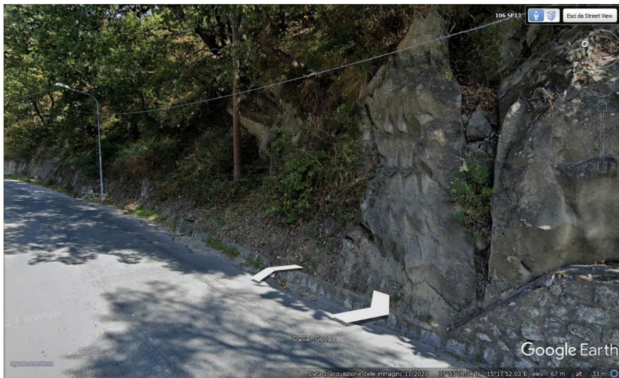
Figura 9 – Fotografia scattata in corrispondenza del segnaposto VI03-3.
