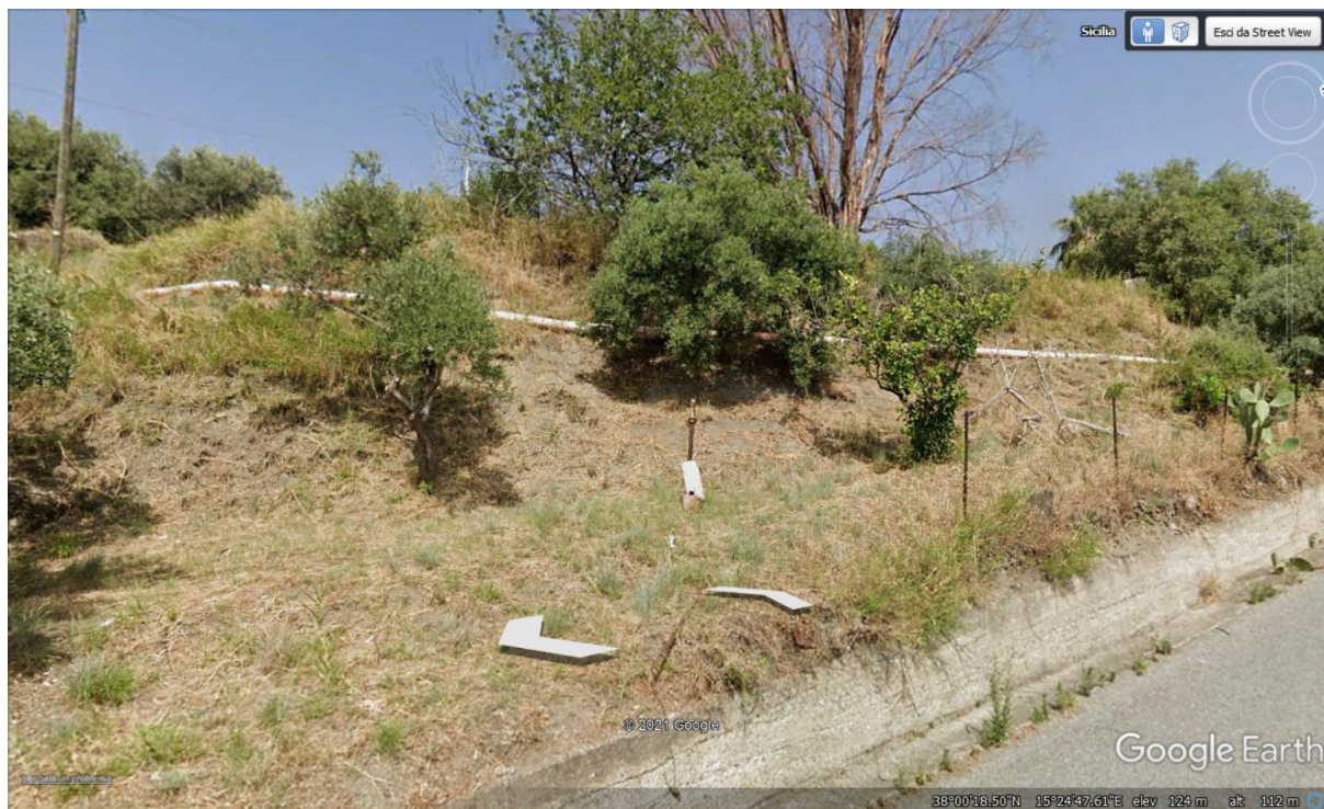
Figura 46 – Fotografia scattata in corrispondenza del segnaposto VI07-3.
