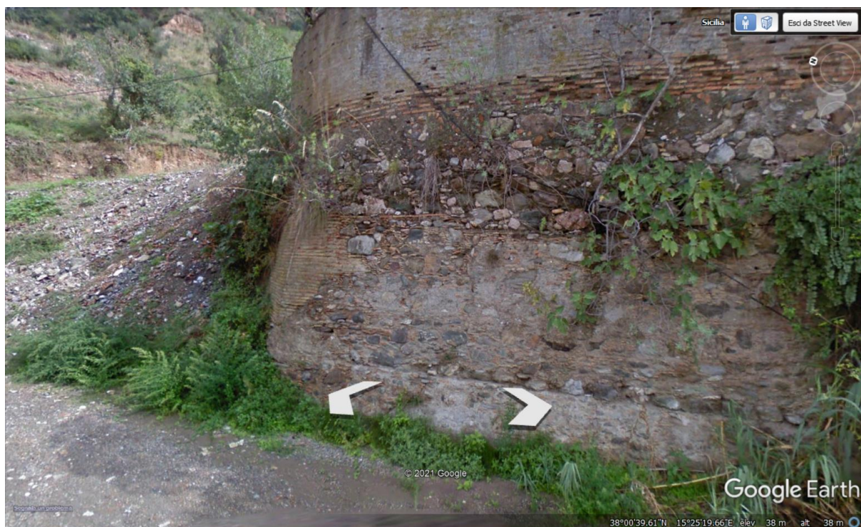
Figura 50 – Fotografia scattata in corrispondenza del segnaposto VI08-1.
