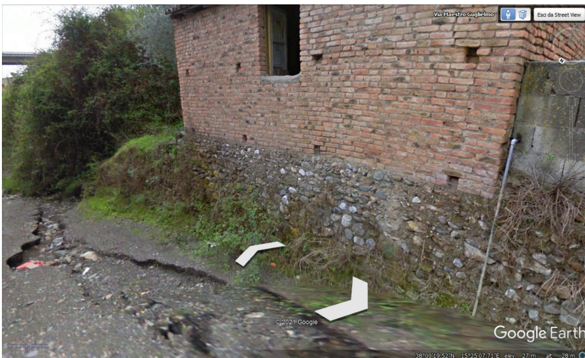
Figura 42 – Fotografia scattata in corrispondenza del segnaposto VI07-2.
