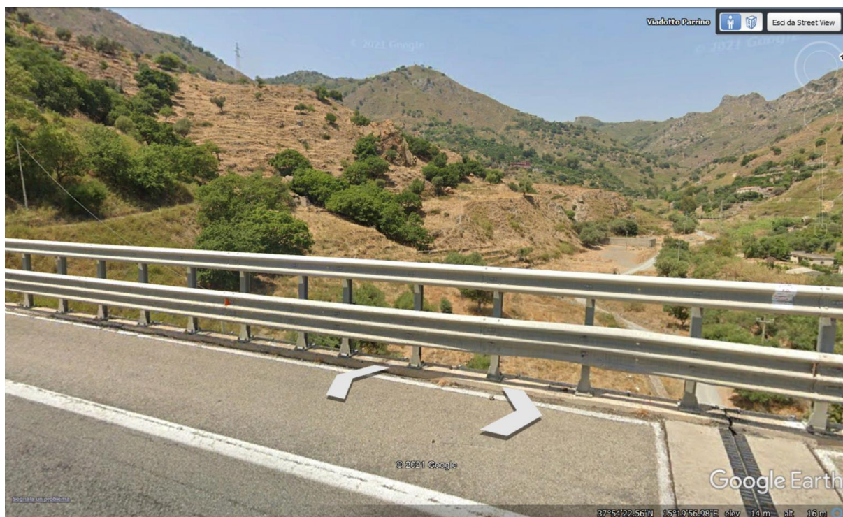
Figura 19 – Fotografia scattata in corrispondenza del segnaposto VI04.2.
