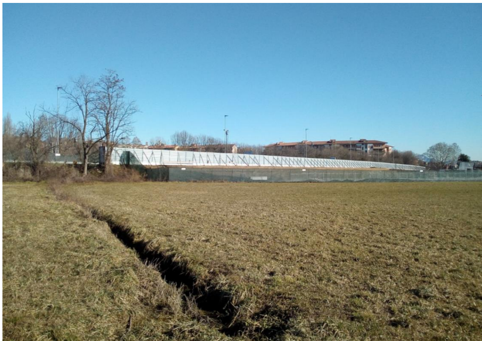
Foto 1 – Vista del Cantiere
