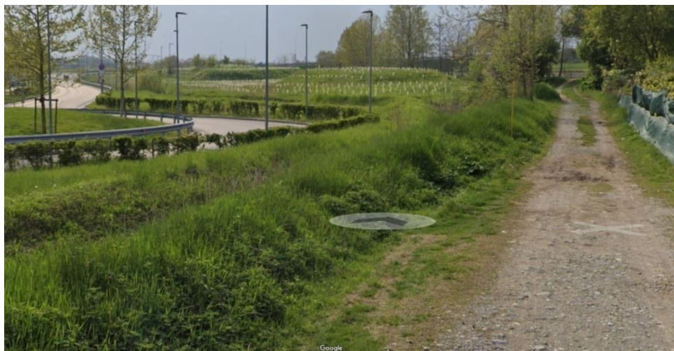
Foto 2 – Vista dalla poderale lungo la ferrovia della rotatoria lato sud (fonte google street view)
