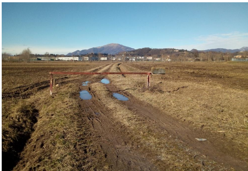
Foto 2 - Vista del tratturo esistente da adattare a pista di cantiere
