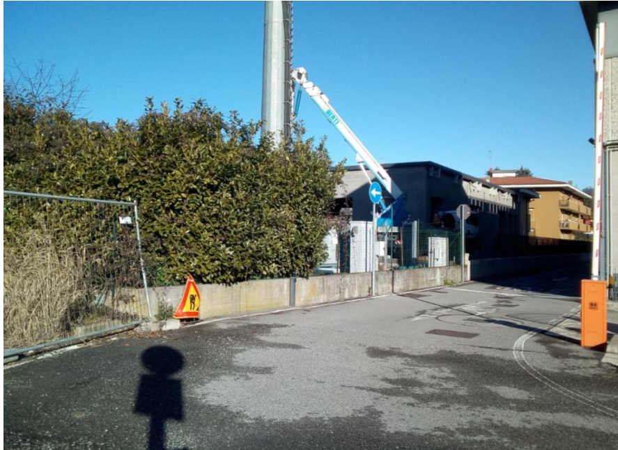
Vista del tratto di via Manzù a senso unico e sezione ridotta
