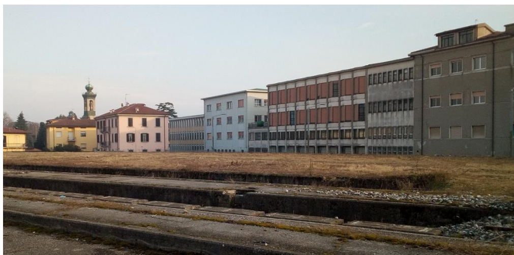
Foto 1 – Vista del cantiere dalla pista di accesso
