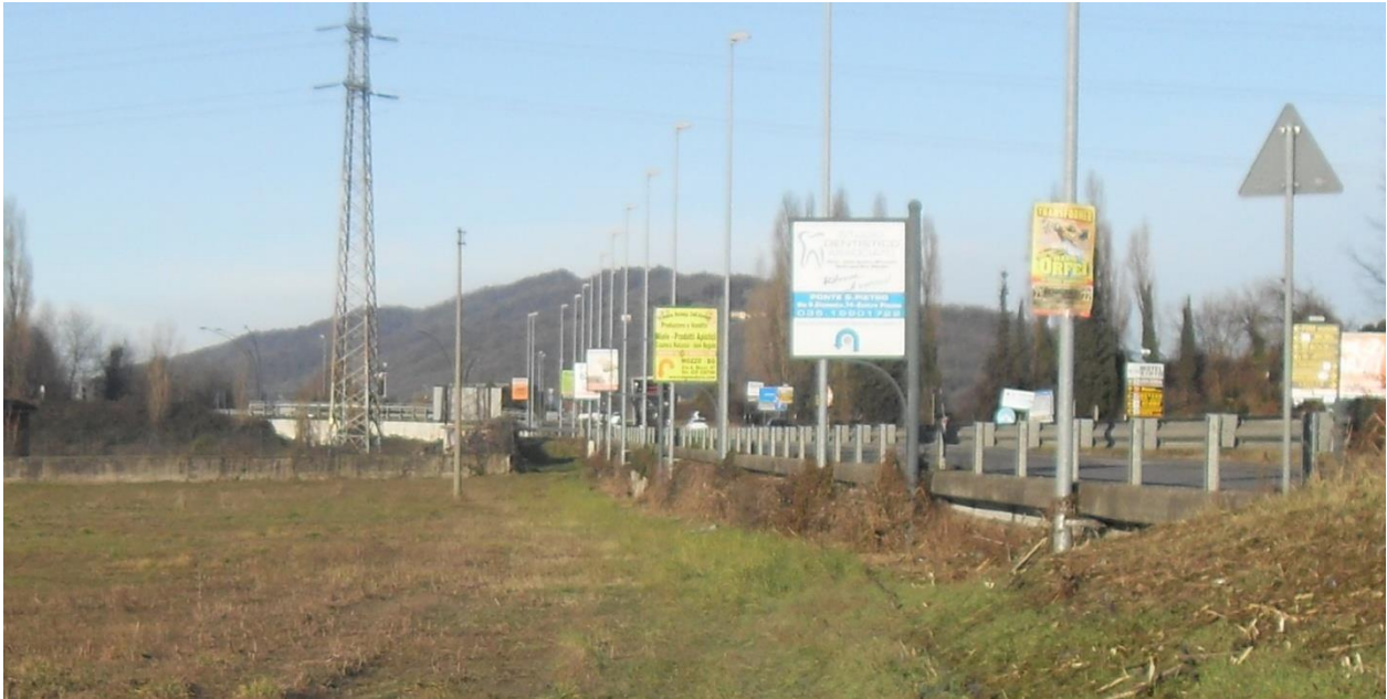
Foto 1 – Vista rampa di discesa/pista d'accesso (fonte sopralluogo)
