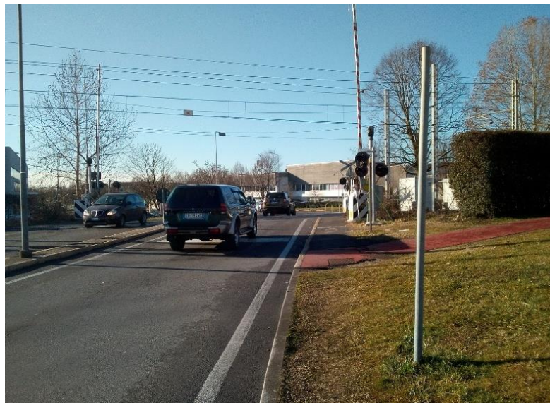
Foto 2 – vista dell'area di cantiere (via Fermi) 1.AS.12
