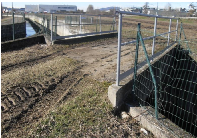
Vista di uno degli attraversamenti idraulici presenti nell'area
