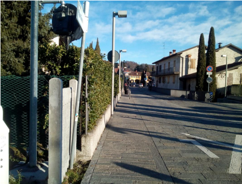
Foto1 - Vista del cantiere 1.AT.01 (fonte sopralluogo)
