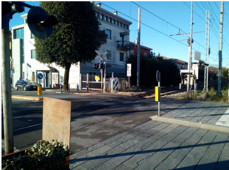
Foto2 - Vista del cantiere 1.AT.01 (fonte sopralluogo)
