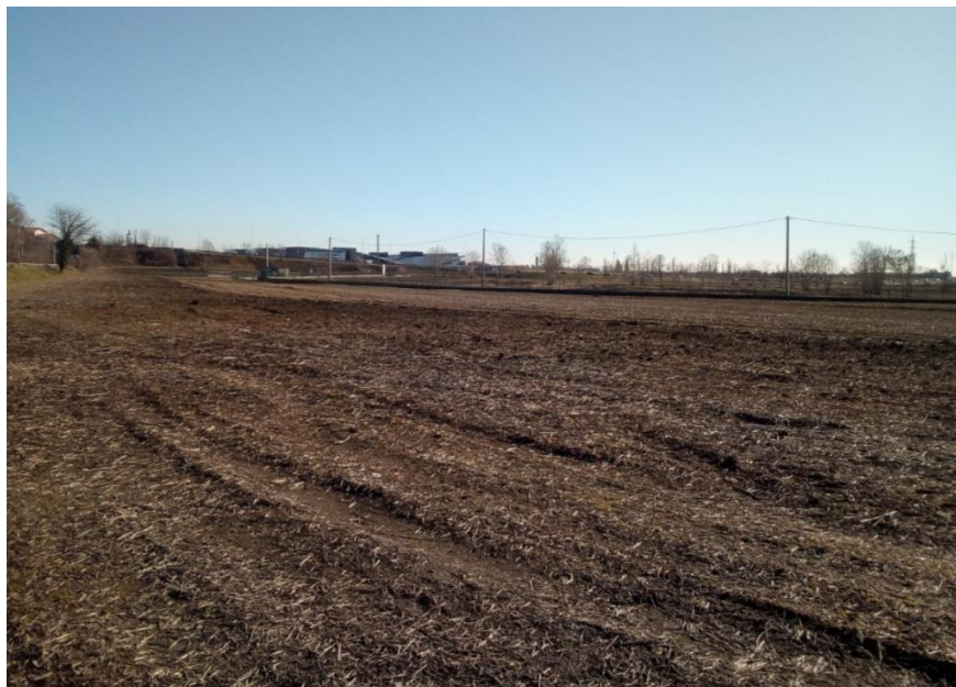
Foto1 - Vista del cantiere 1.DT.01 (fonte sopralluogo)
