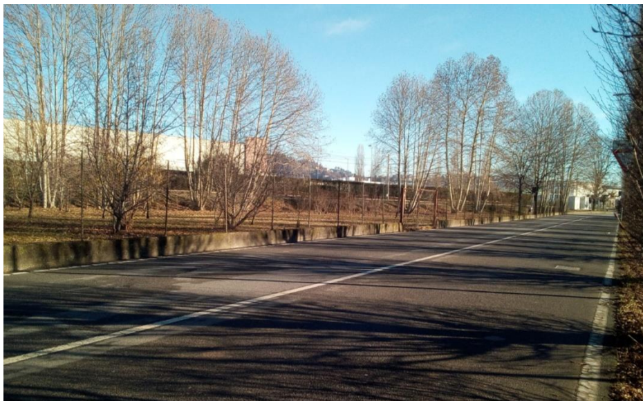
Foto 1 - Vista del cantiere CO.02 - (fonte sopralluogo)
