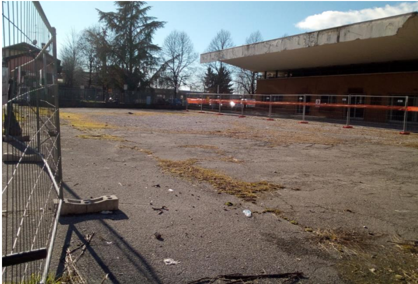
Foto1 - Vista dell'area di cantiere AS.06
