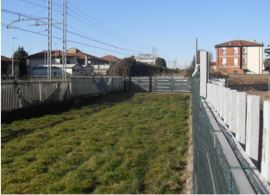
Foto 1 - Vista del cantiere CO.01 (fonte sopralluogo)
