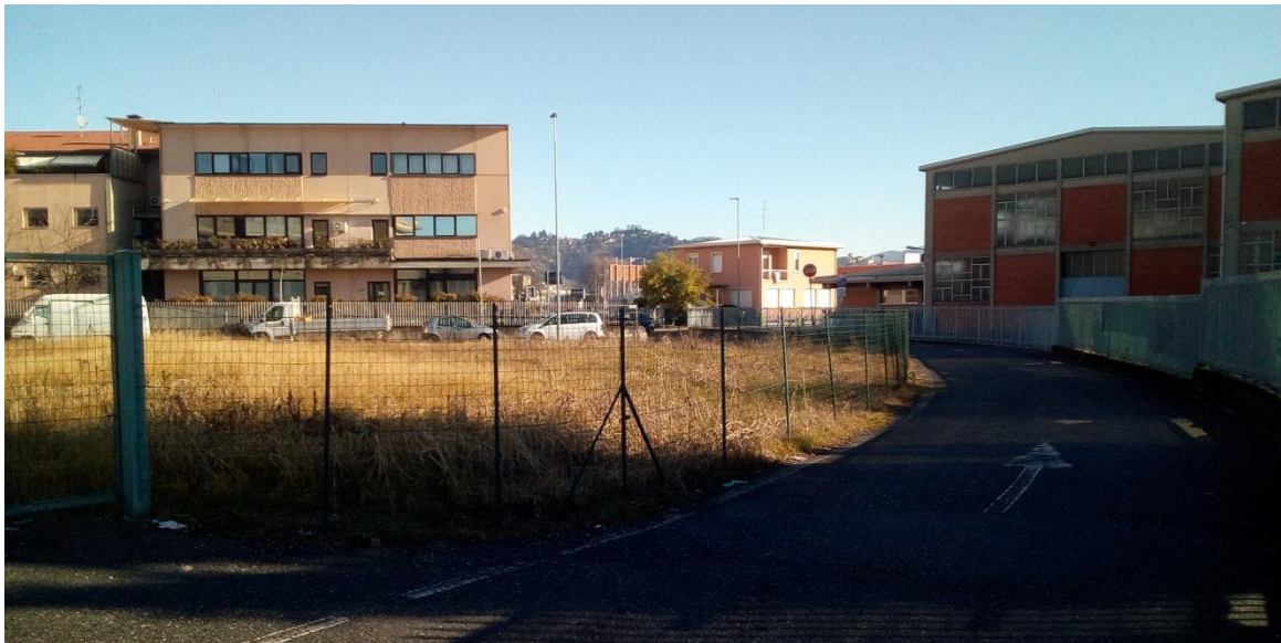
Foto 1 - Vista del cantiere 1.AS.01
