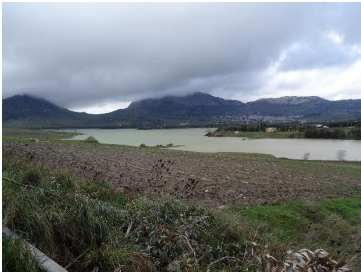
Figura 24: Serbatoio di Piana degli Albanesi - vista d'insieme
