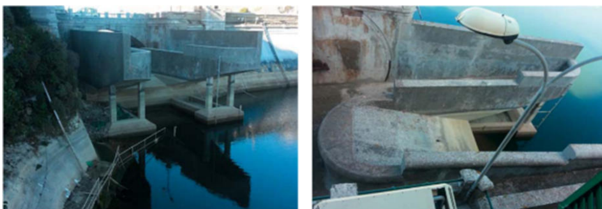
Figura 5: Lo sfioratore (scarico di superficie) della diga di Piana degli Albanesi (Ferla & Jappelli, 2014)
