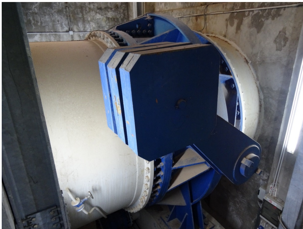
Figura 14: Valvola a farfalla di destra.
