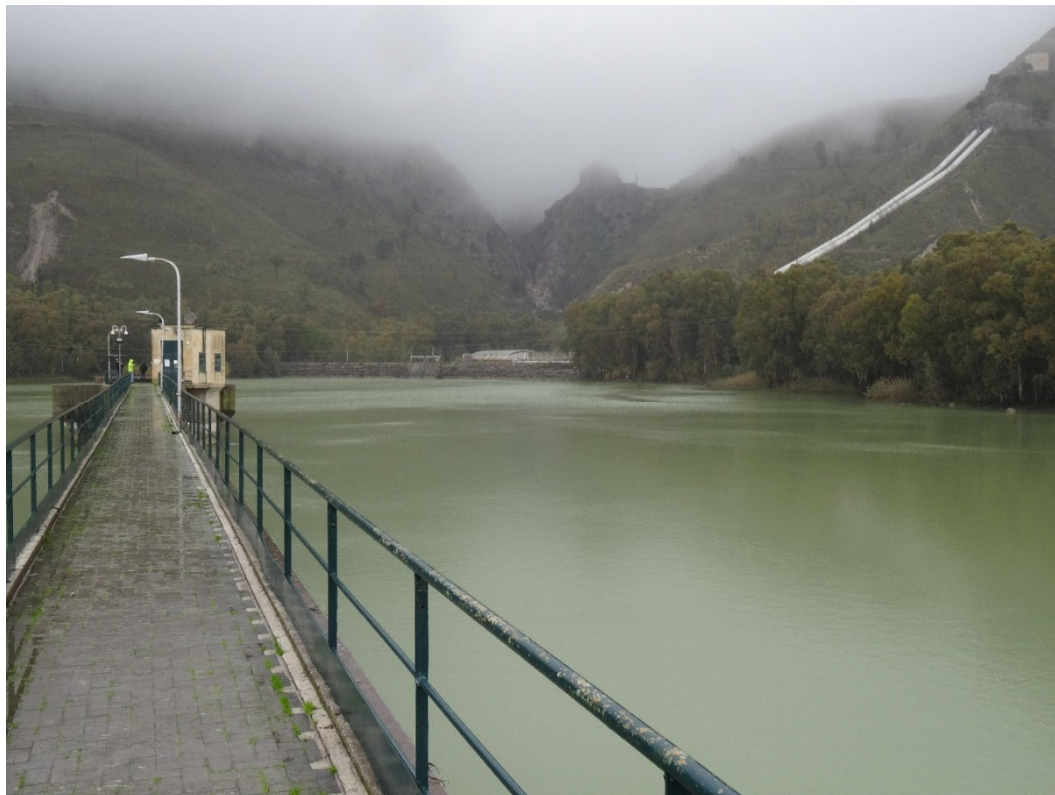
Figura 42: Diga di Guadalami: passerella di accesso allo scarico di superficie ed alla cabina di manovra.
