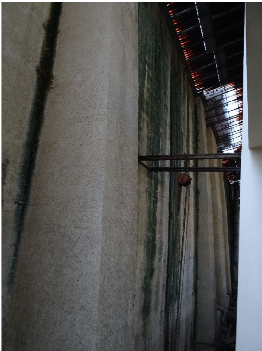
Figura 25: Centrale di Guadalami: muro della vasca di scarico.
