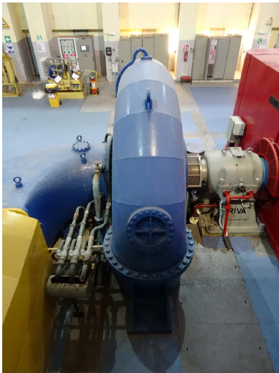
Figura 26: Centrale di Guadalami: Turbina Francis Gr. 3.
