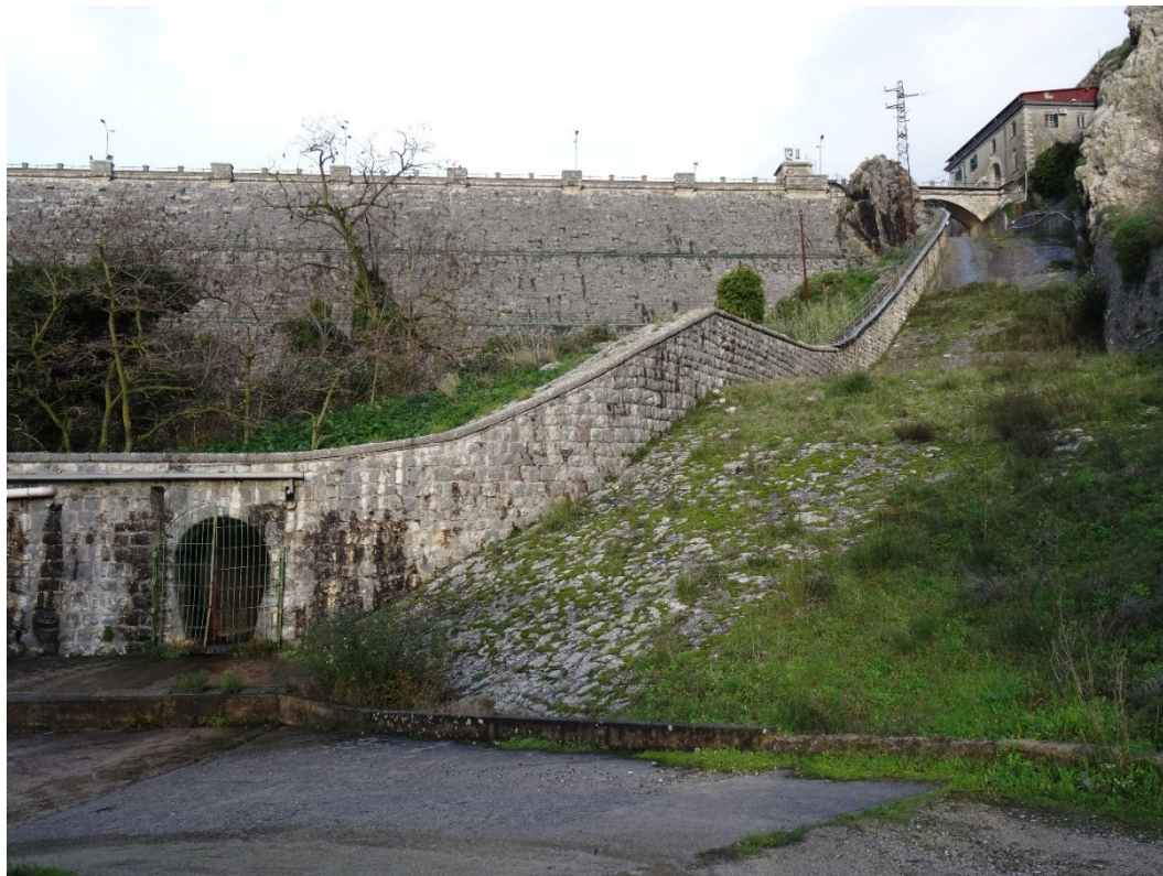
Figura 6: Diga di Piana degli Albanesi: vista da valle verso lo scarico di superficie.
