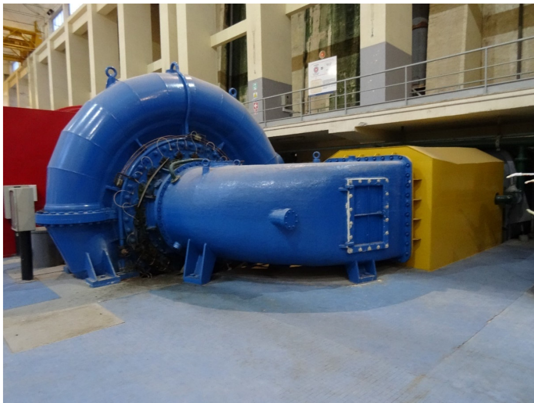
Figura 28: Centrale di Guadalami: Turbina Francis Gr. 3.
