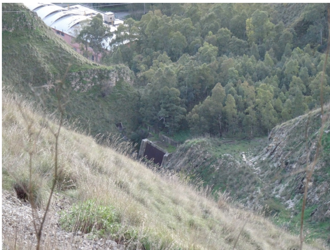
Figura 22: Opera di presa del canale di bypass dell'alveo naturale del Belice destro (bypass della centrale).
