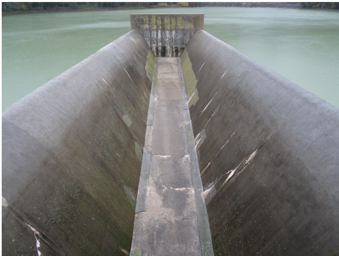
Figura 43: Diga di Guadalami: scarico di superficie.
