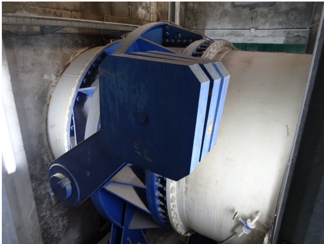
Figura 15: Valvola a farfalla di sinistra.
