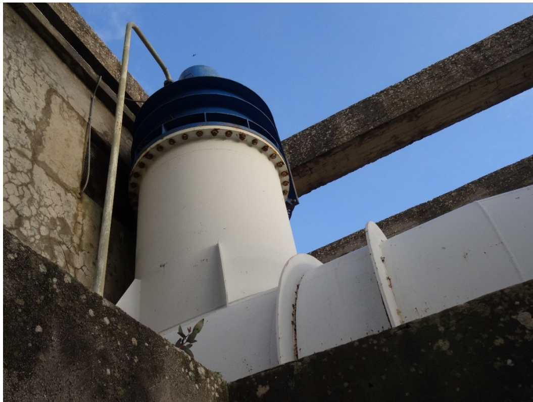
Figura 10: Valvola di rientrata d'aria sinistra.
