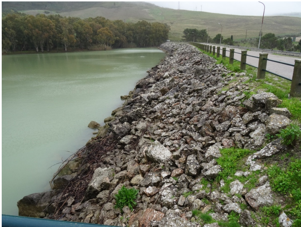
Figura 40: Diga di Guadalami: paramento di monte.
