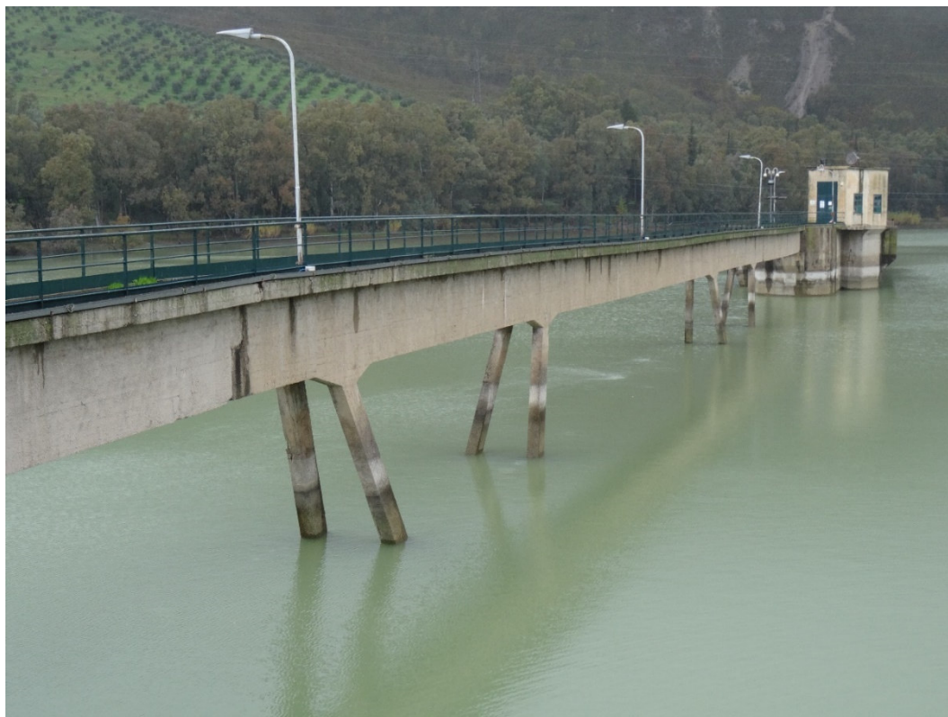
Figura 41: Diga di Guadalami: passerella di accesso allo scarico di superficie ed alla cabina di manovra.
