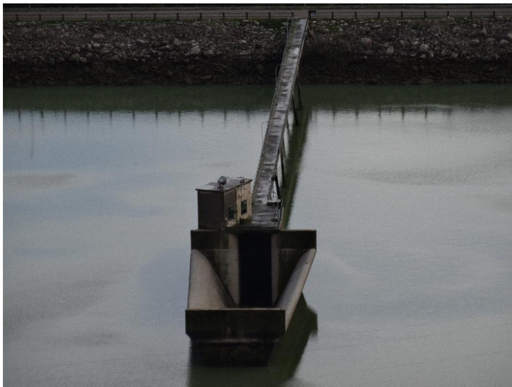
Figura 37: Lago di Guadalmi: sfioratore con passerella d'accesso.
