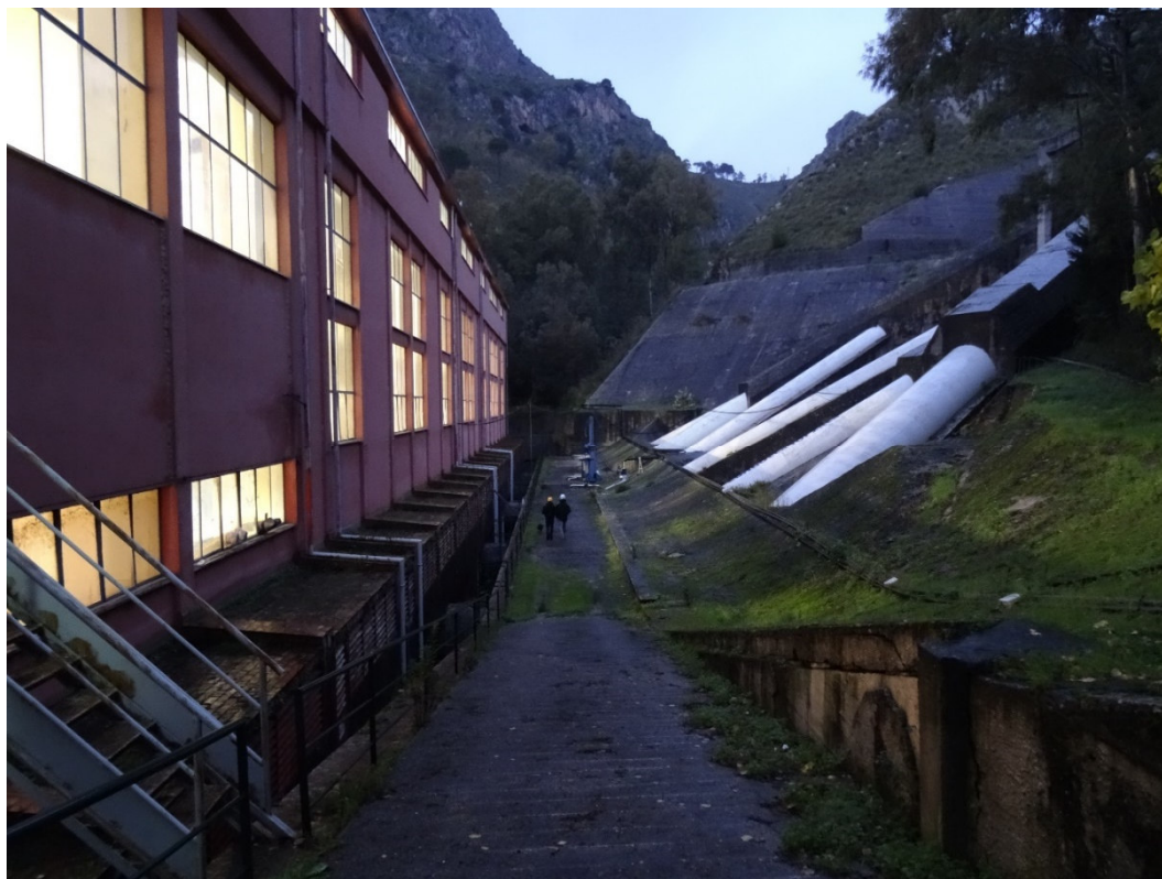
Figura 18: Condotte forzate: triforcazioni ed entrata in centrale.
