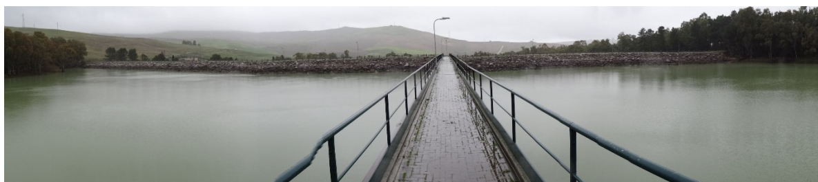
Figura 44: Diga di Guadalami: vista panoramica dalla passerella dello scarico di superficie
