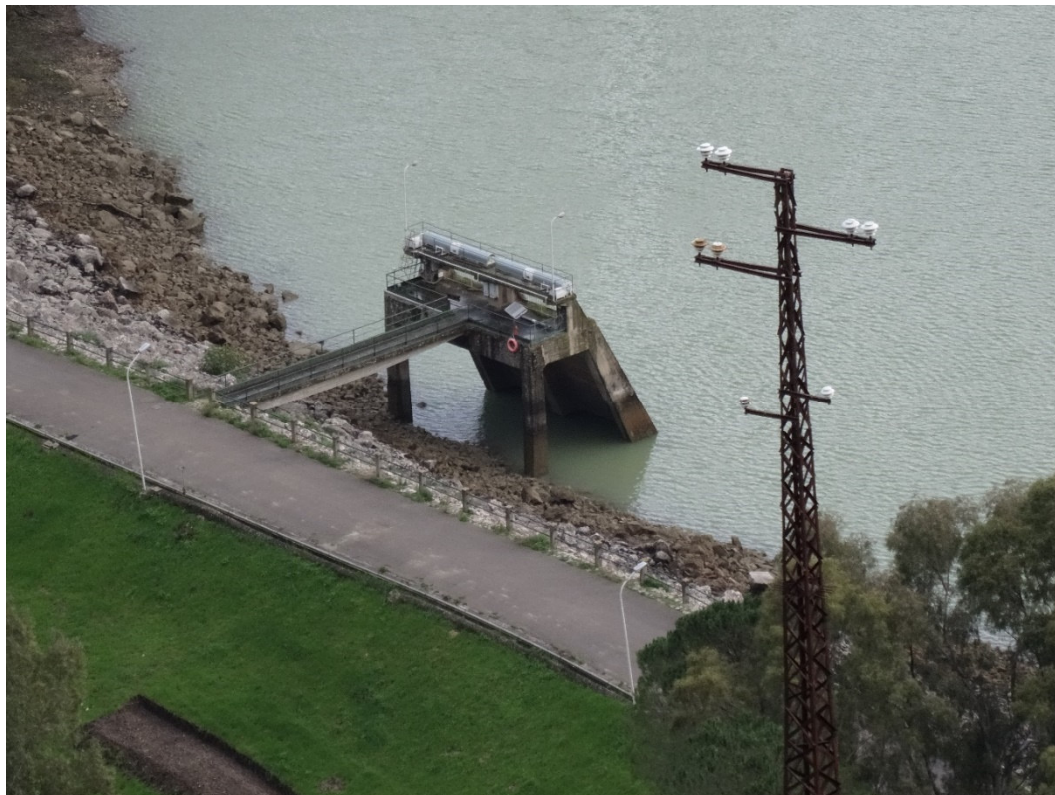
Figura 38: Lago di Guadalmi: opere non immerse del canale di scarico sulla diga di monte.
