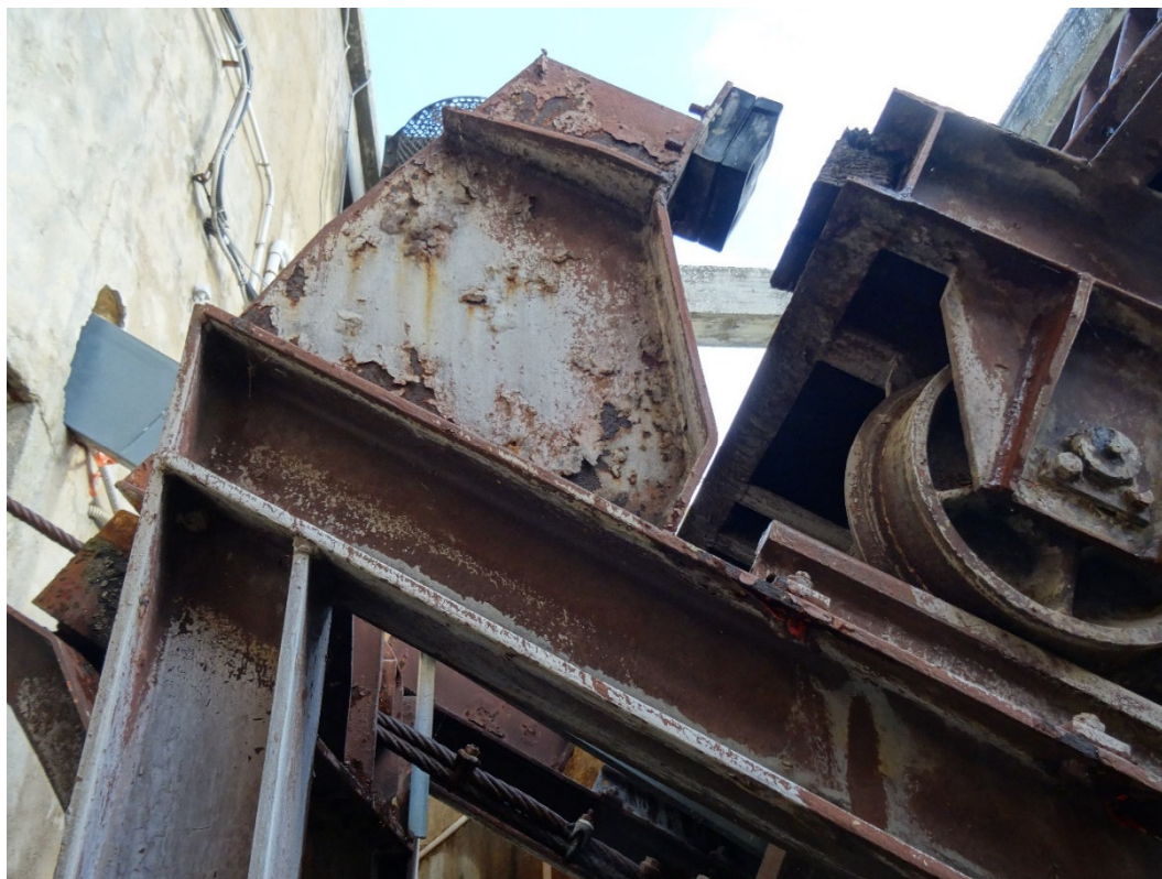
Figura 16: Piano inclinato per il montaggio della condotta.
