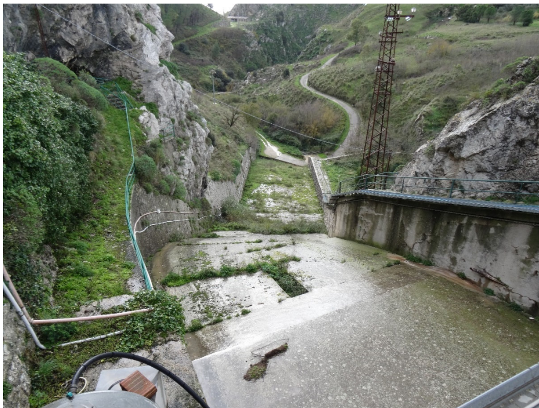
Figura 5: Diga di Piana degli Albanesi: vista da monte del canale dello scarico di superficie.
