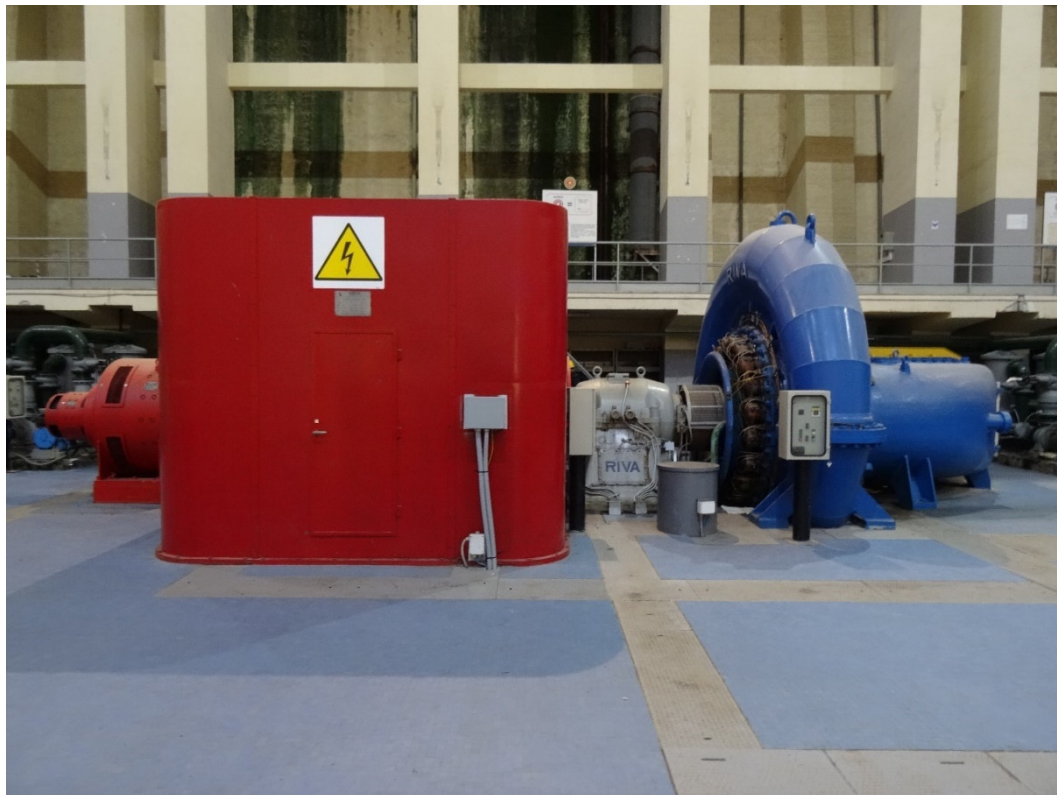
Figura 29: Centrale di Guadalami: Gr. 3., zona oggetto di intervento.
