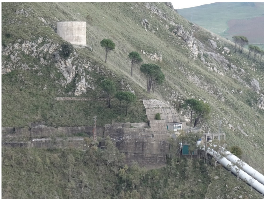
Figura 7: Pozzo piezometrico e camera valvole: vista dalla sponda destra.
