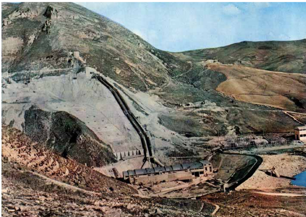
Figura 8: Vista, da ovest verso est, con lo sbocco del pozzo piezometrico, la condotta forzata, la centrale Guadalmi e la diga di monte dell'invaso [6].
