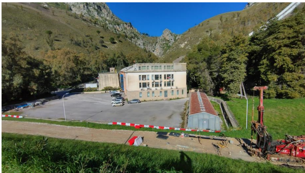
Figura 4: Vista della centrale dal coronamento della diga di monte.
