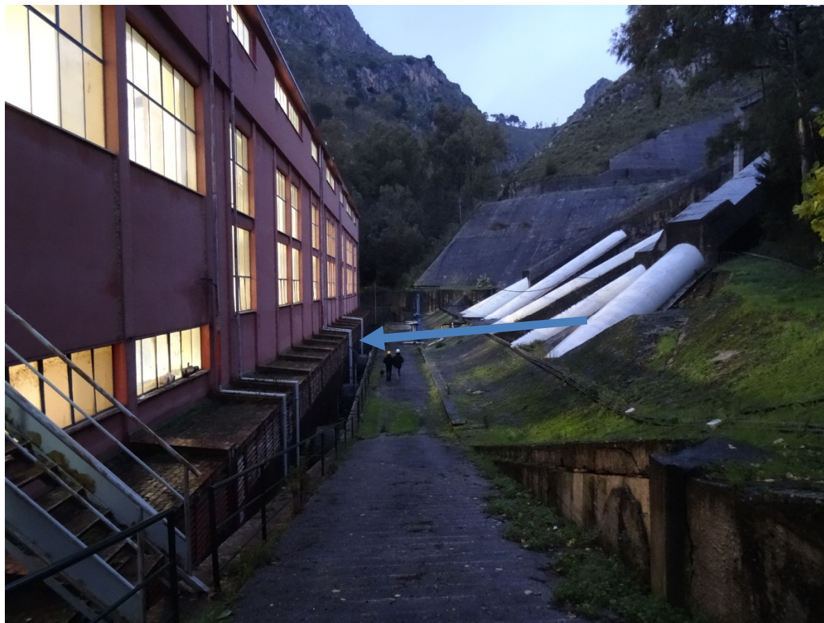
Figura 5: Pista di accesso alla finestrata; la freccia blu segnala la possibile entrata in centrale.
