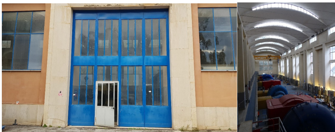
Figura 3: Portone principale di accesso
