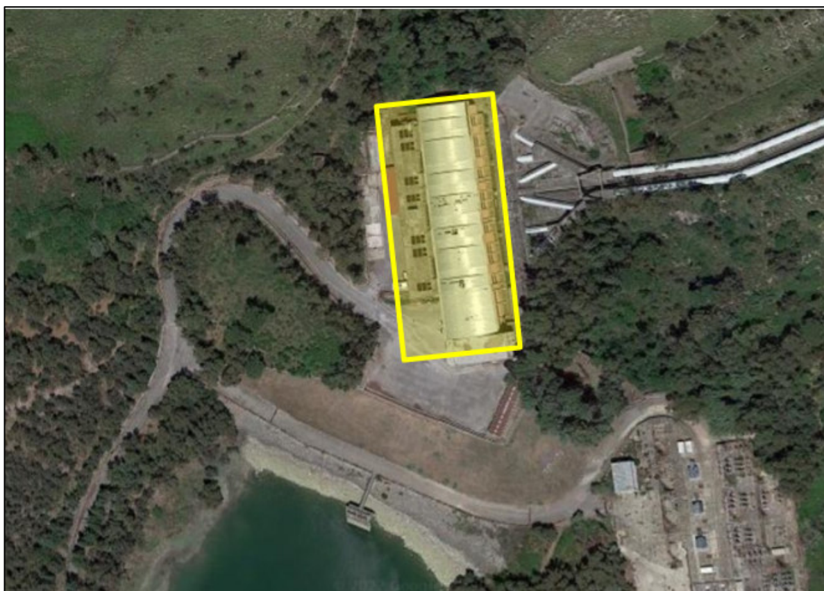
Figura 2-4: Manufatto principale della centrale di Guadalami che ospita il Gruppo 3 in sostituzione
