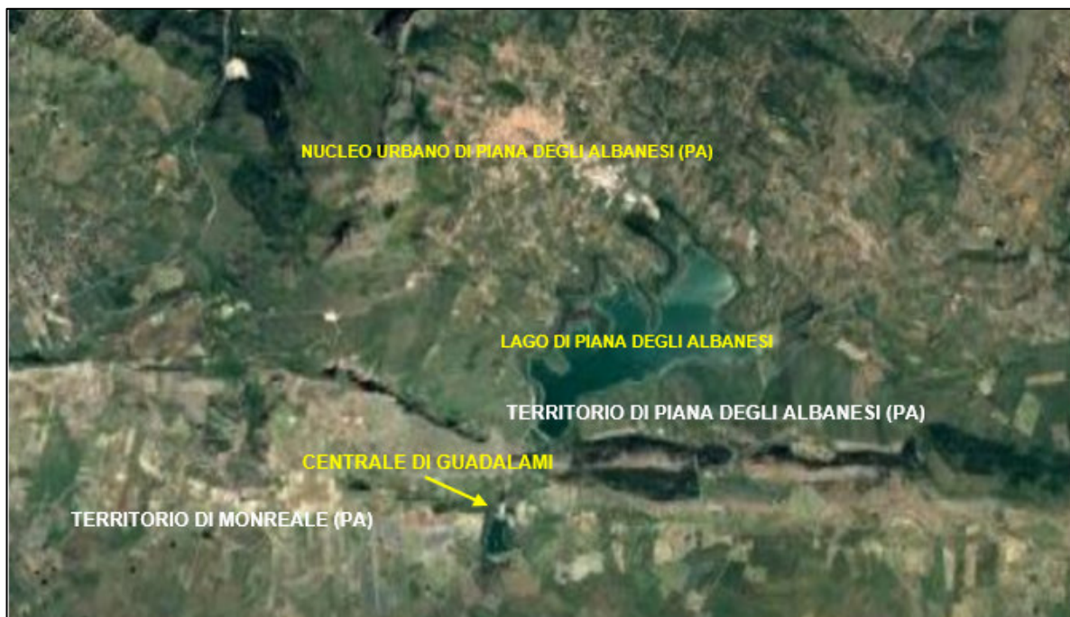
Figura 2-1: Inquadramento generale su ortofoto della centrale di Guadalami
